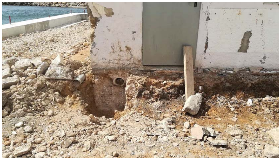
Cimiento fachada Norte
