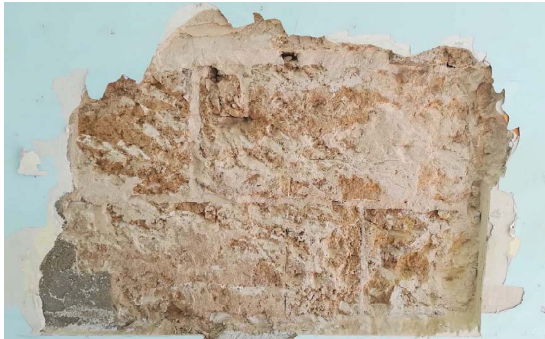
Fotografía 3 Cata M_5. Mampostería de marés
