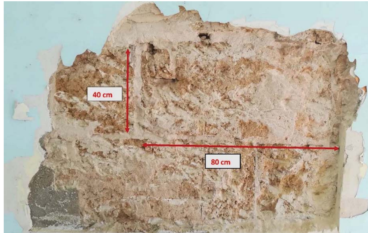
Fotografía 13. Medidas bloque de marés. Cata M_5 ampliada
