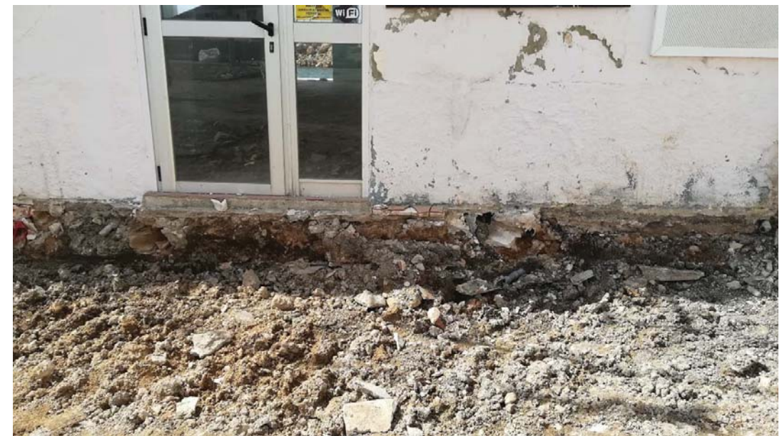
Cimiento fachada Norte
