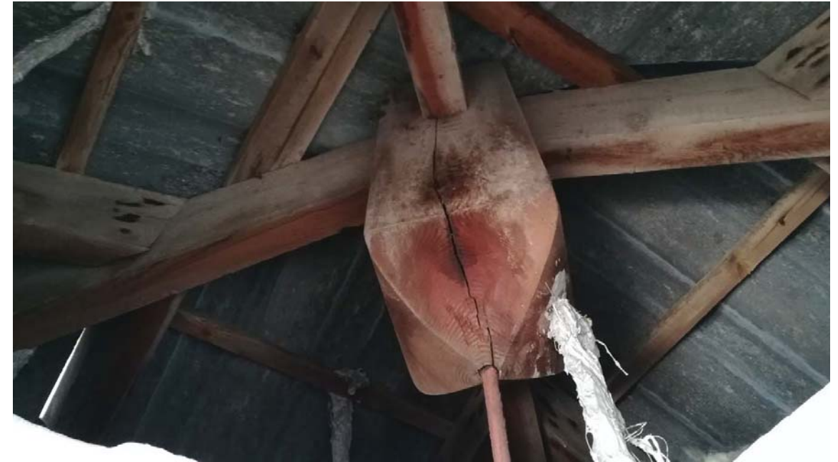
Fotografía 33. Vista general de la estructura de madera de la cubierta
