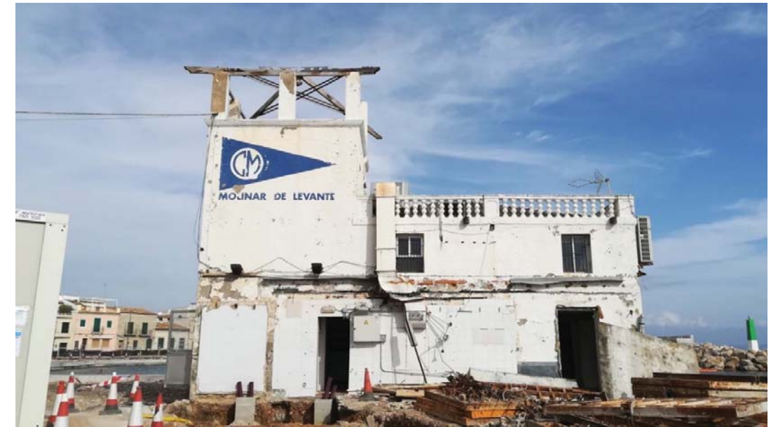
Vista general fachada Oeste
