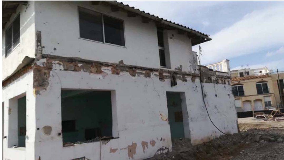
Vista general fachada Este
