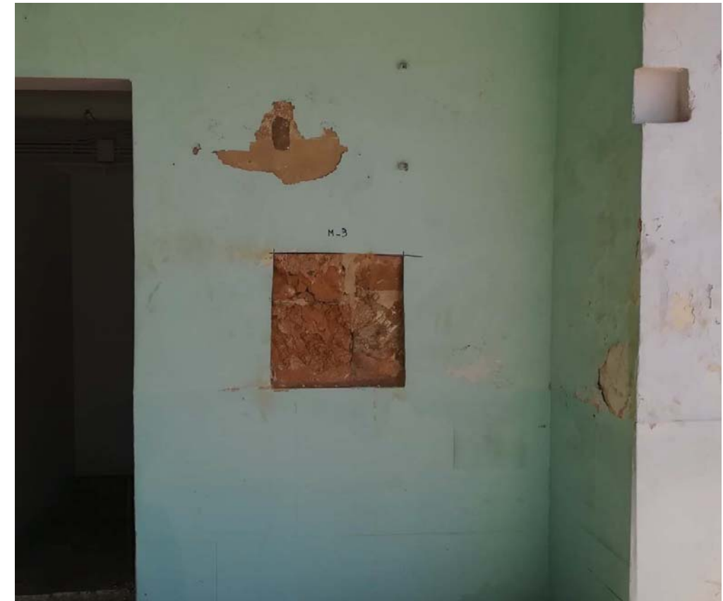
Fotografía 7. Vista general Cata M_3
