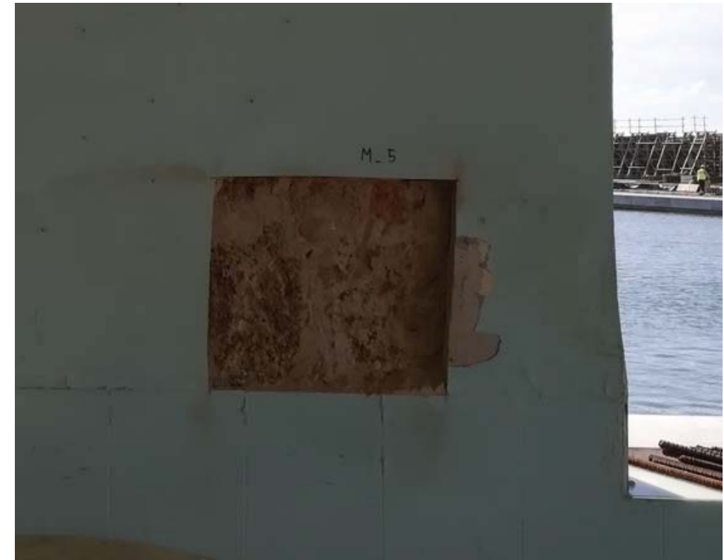
Fotografía 11. Vista general Cata M_5
