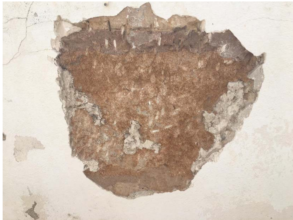
Fotografía 26. Vista detalle cata en torreón M_12a
