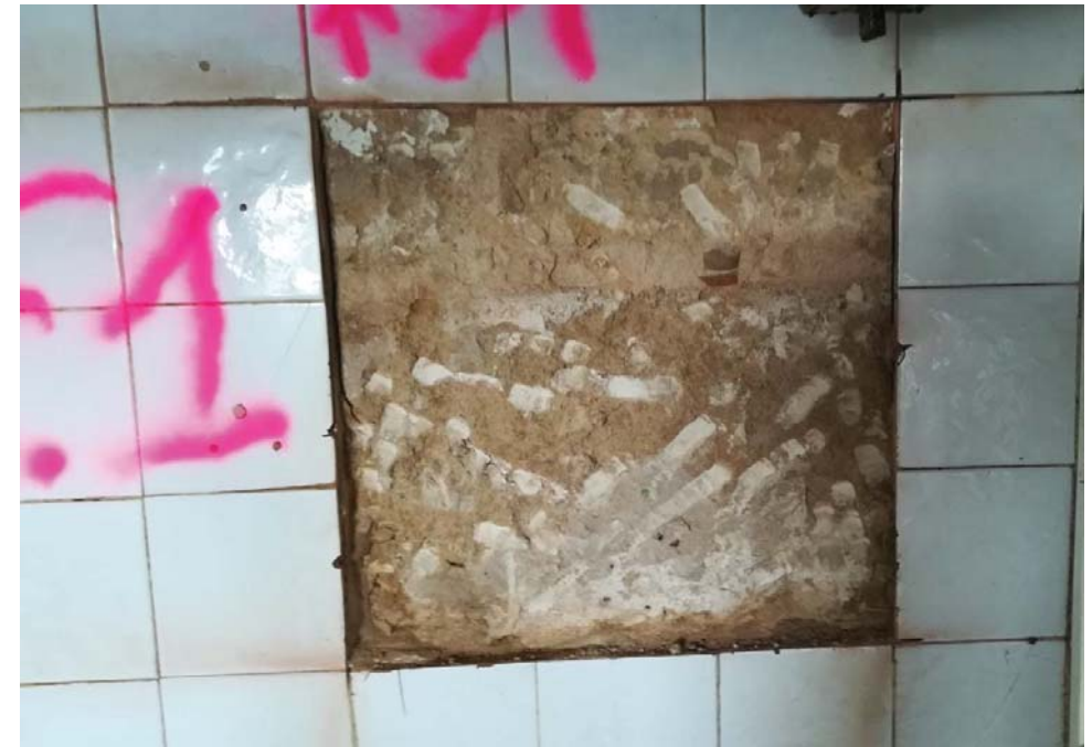
Fotografía 15. Vista general cata M_6
