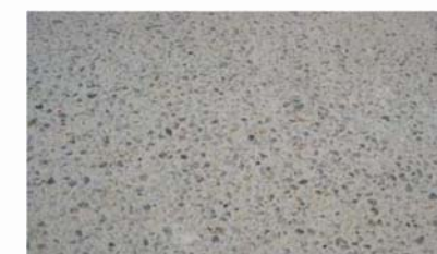
Aspeto final da superfície tratada
