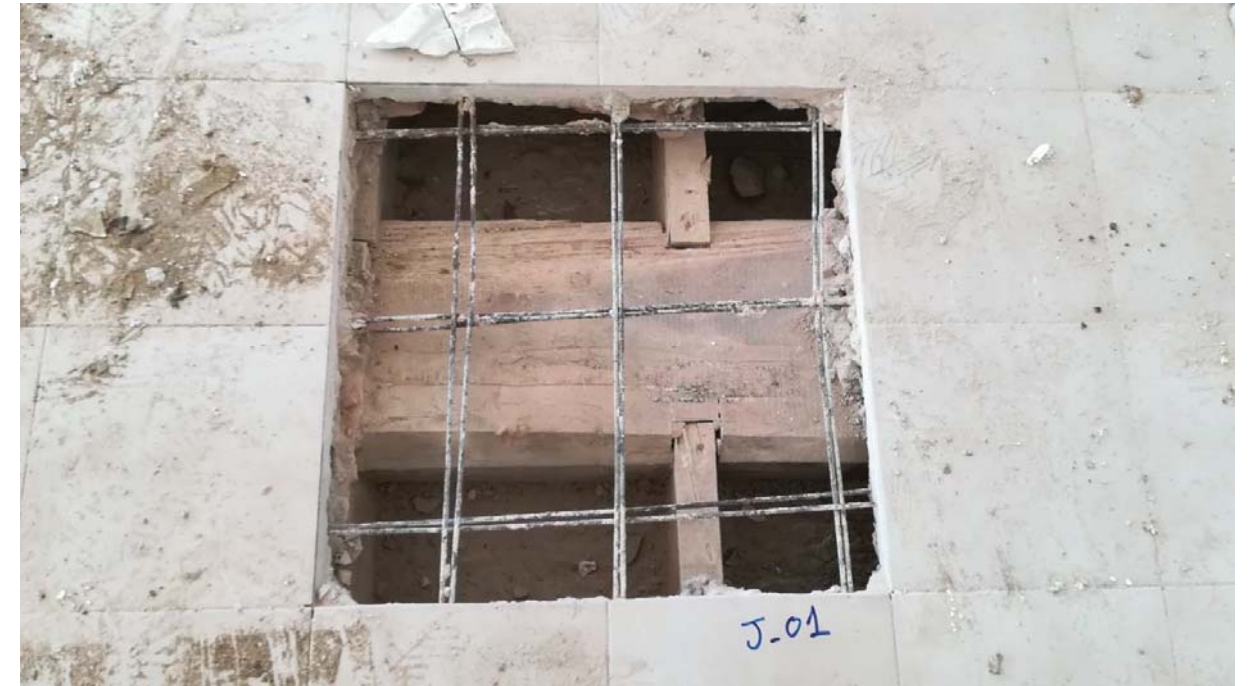
Fotografía 39. Vista general de la cata JI_1
