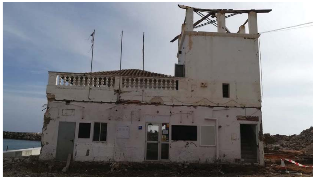
Vista general fachada Norte
