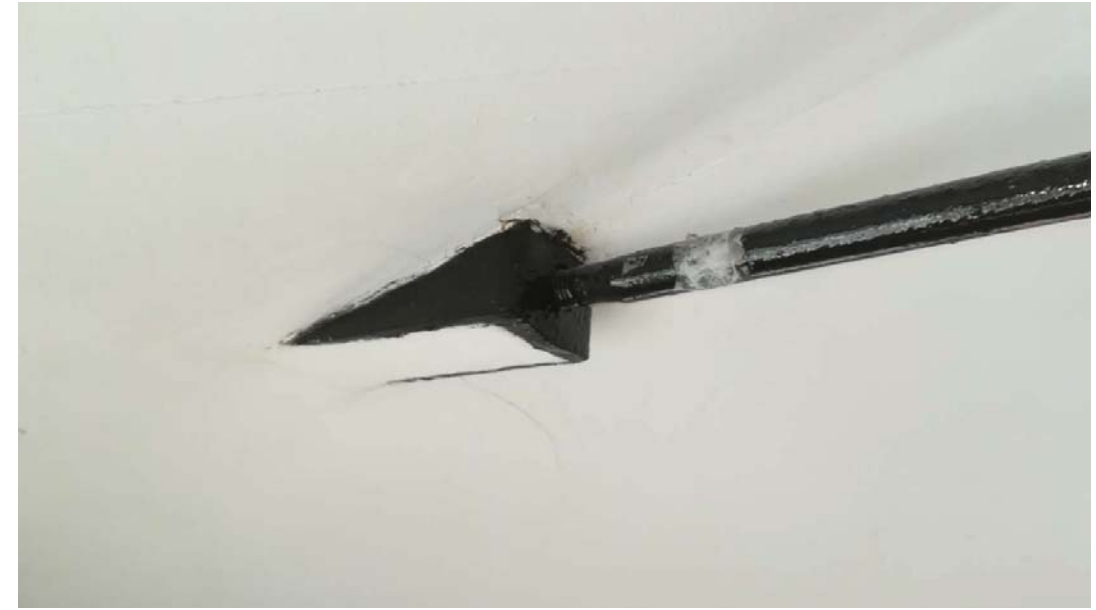
Detalle anclaje tirante
