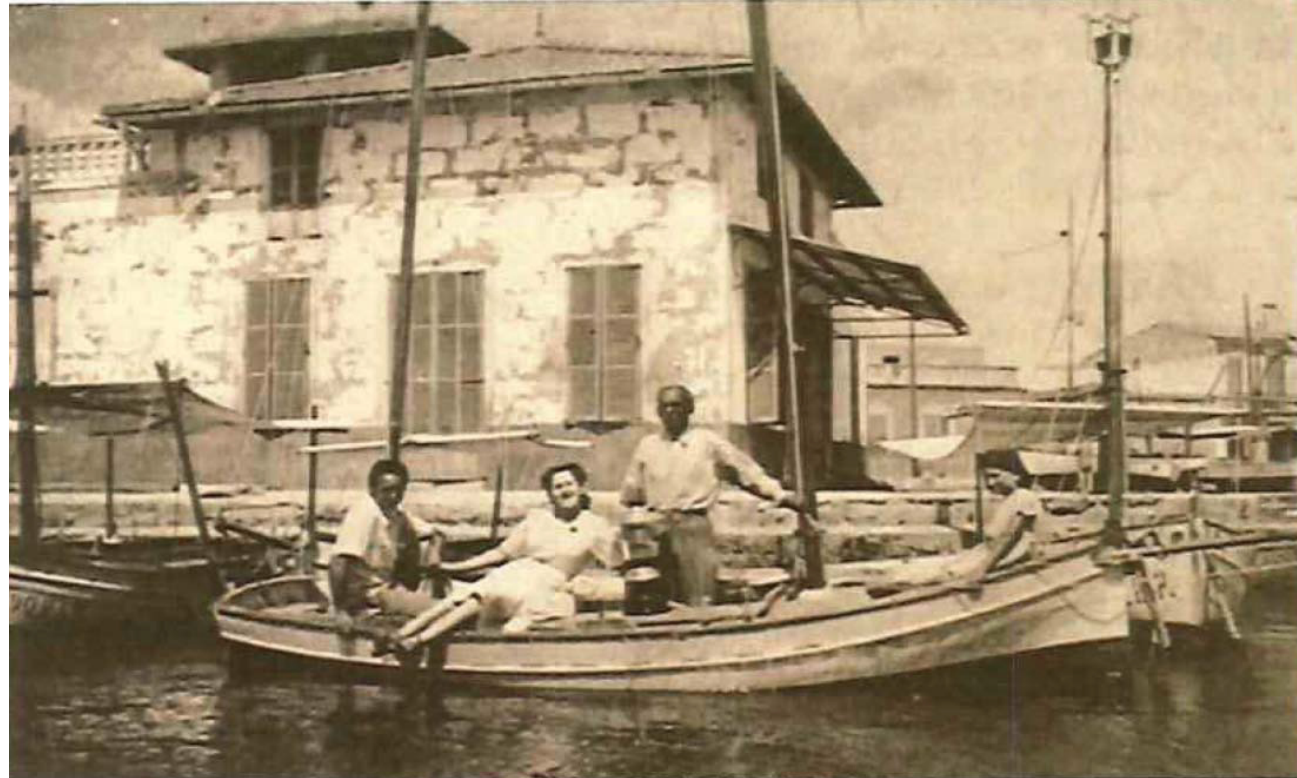
Figura 4. Foto histórica de la fachada Sur.
