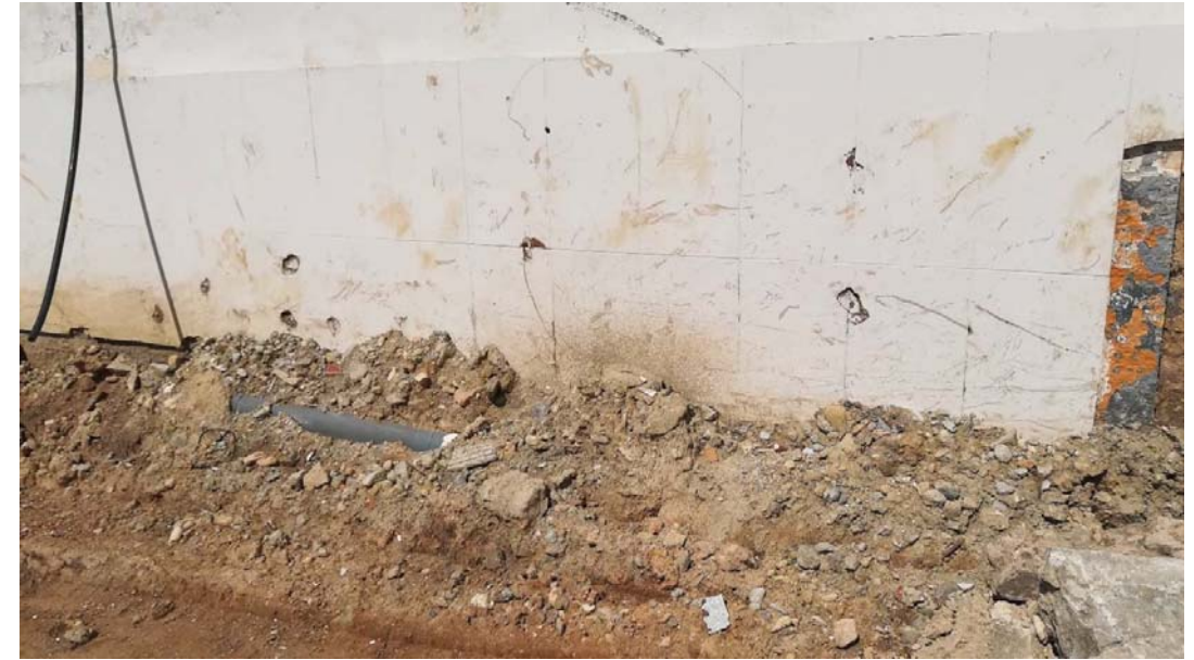
Cimiento fachada Este
