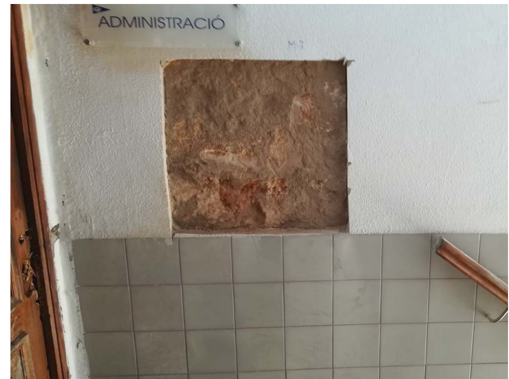
Fotografía 16. Vista general cata M_7
