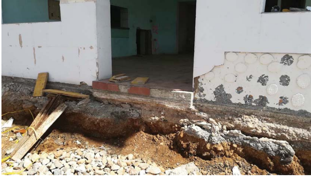
Cimiento fachada Sur
