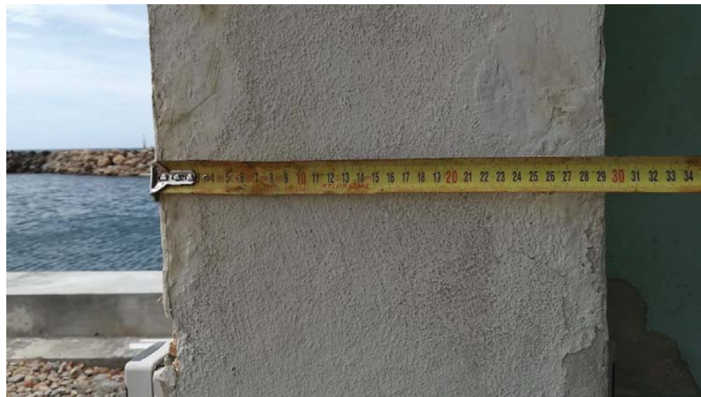
Fotografía 14. Medición del ancho de pared exterior lado levante del edificio
