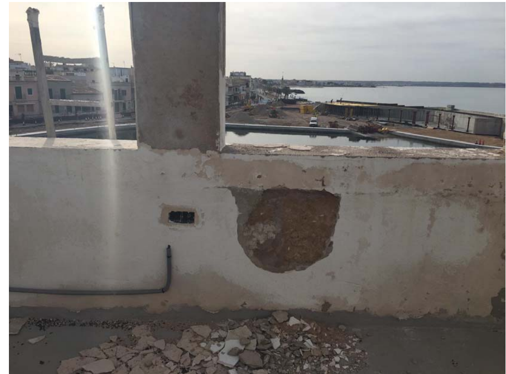
Fotografía 27. Vista general cata en torreón M_12b
