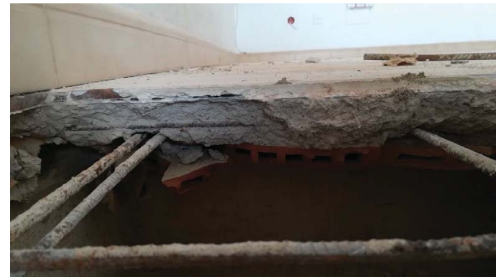
Fotografía 30. Cata SIS_1, vista detalle sección forjado entreplantas
