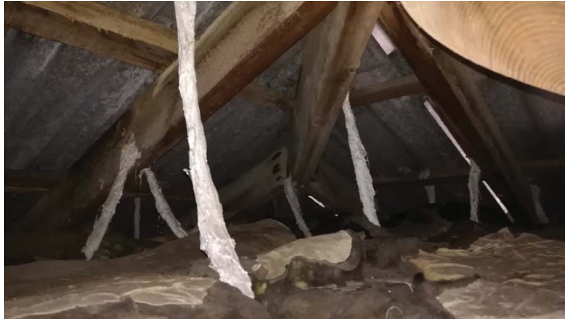
Fotografía 35. Vista general de la estructura de madera de la cubierta
