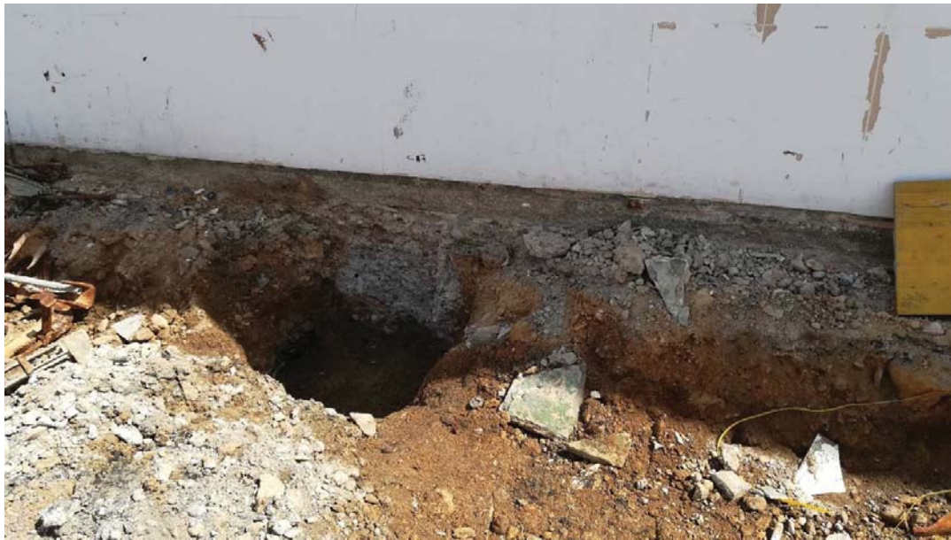
Cimiento fachada Sur
