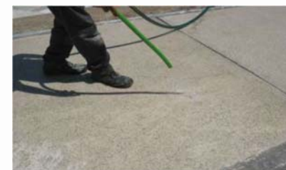
Limpeza da superfície
