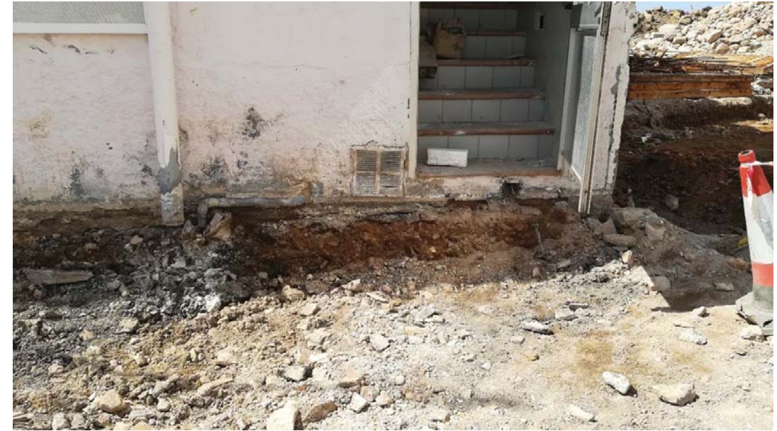
Cimiento fachada Norte
