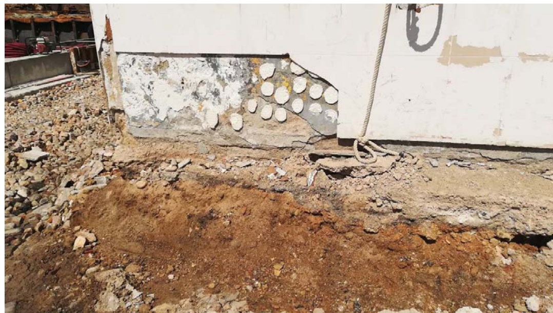
Cimiento fachada Este
