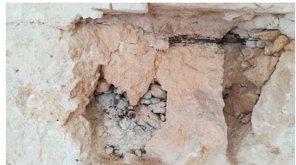
Fotografía 24. Vista detalle cata M_11
