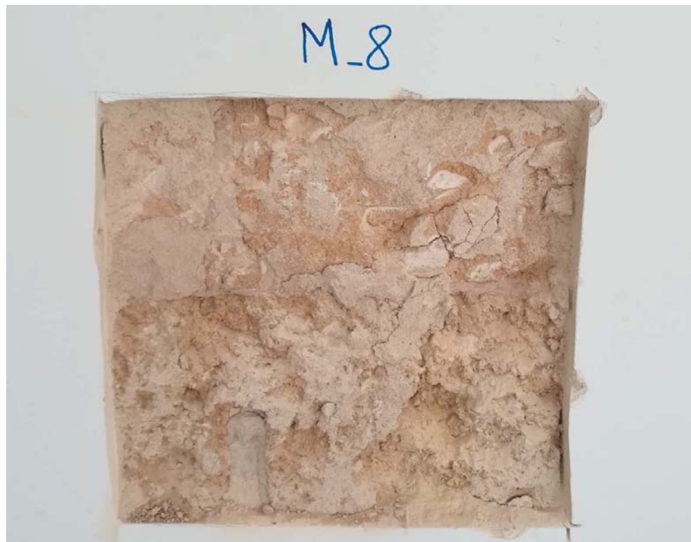
Fotografía 18. Vista detalle cata M_8
