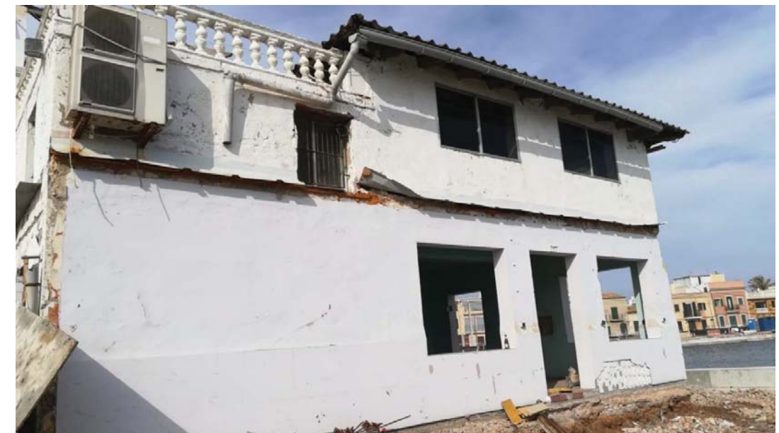
Vista general fachada Sur
