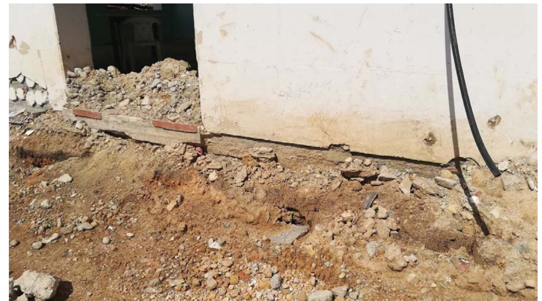
Cimiento fachada Este
