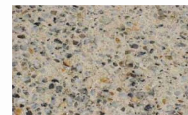
Aplicação do B-REPARA PROTEÇÃO AD 40
