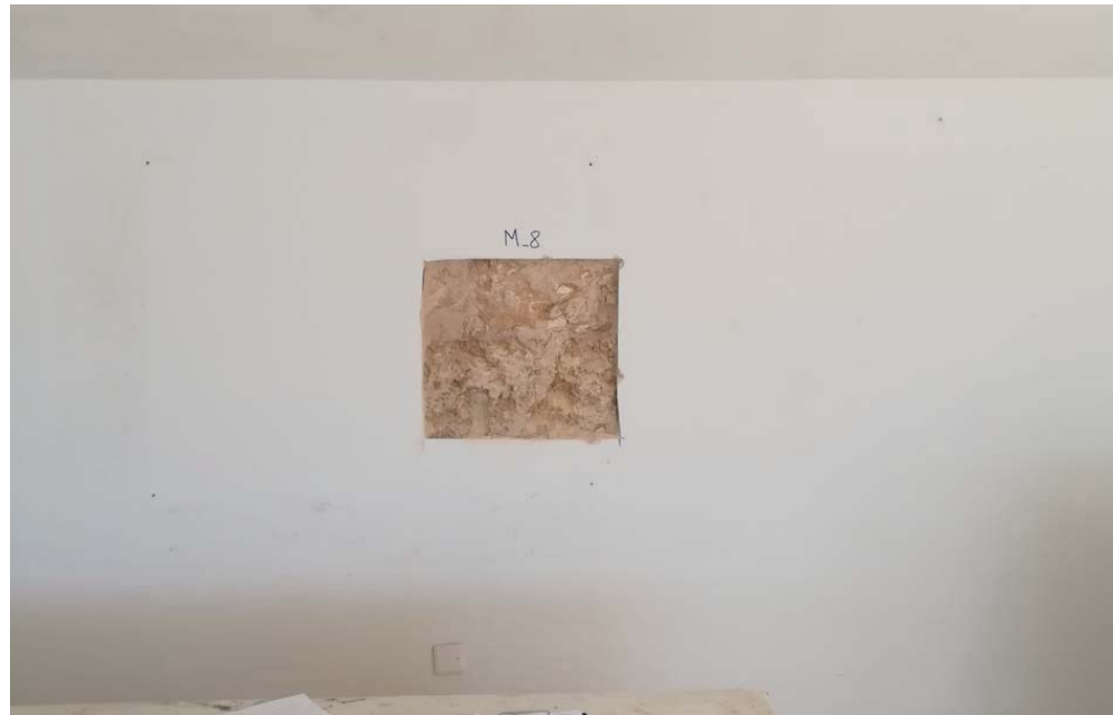
Fotografía 17. Vista general cata M_8
