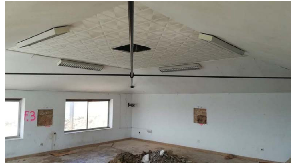
Fotografía 43. Tirantes metálicos entre jácenas opuestas
