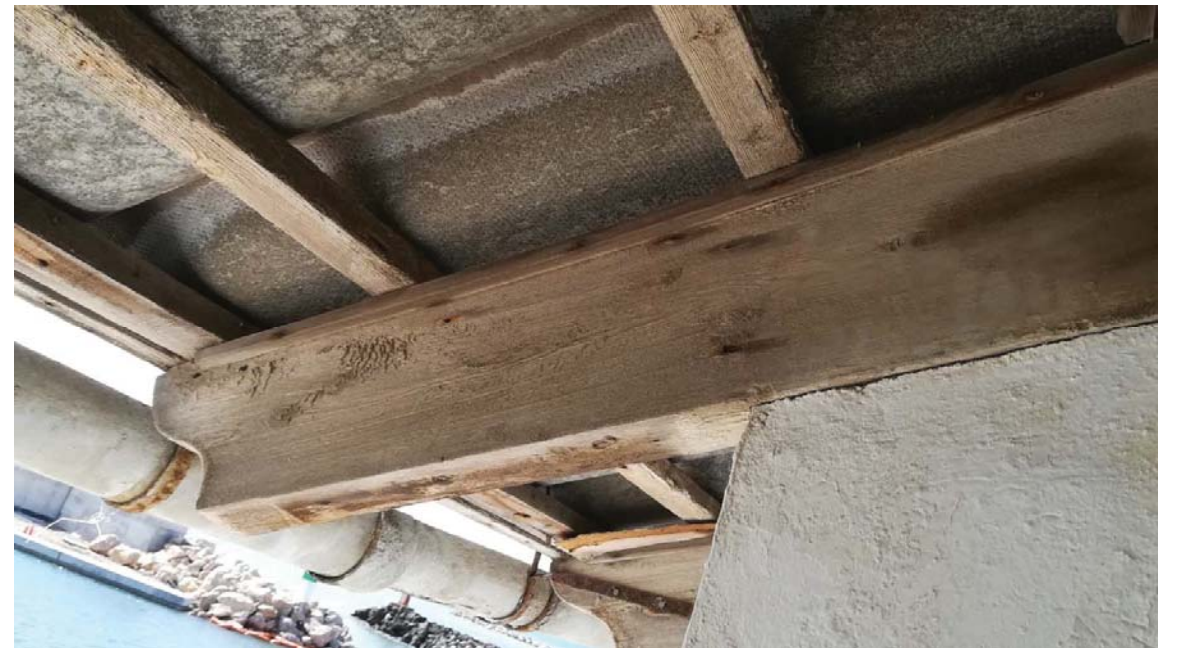
Fotografía 38. Vista general de vigueta y correas de la cubierta
