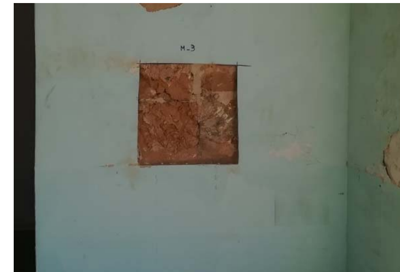
Fotografía 2 Cata M_3 realizada en muro edificio
