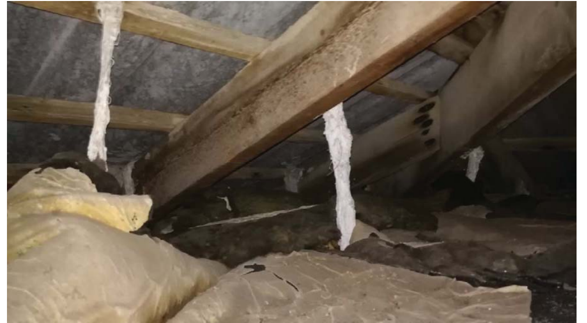
Fotografía 37. Vista general de la estructura de madera de la cubierta
