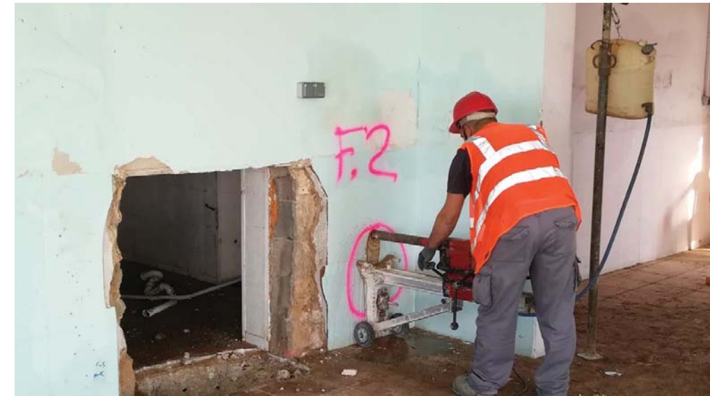
Fotografía 45. Extracción de testigo
