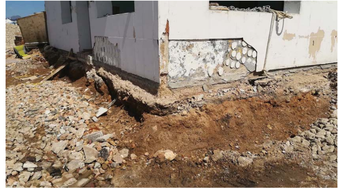
Cimiento esquina Sureste
