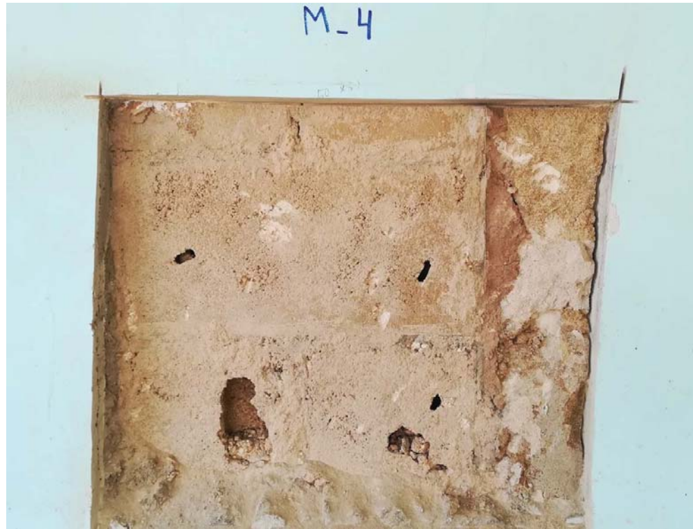
Fotografía 9. Vista detalle Cata M_4
