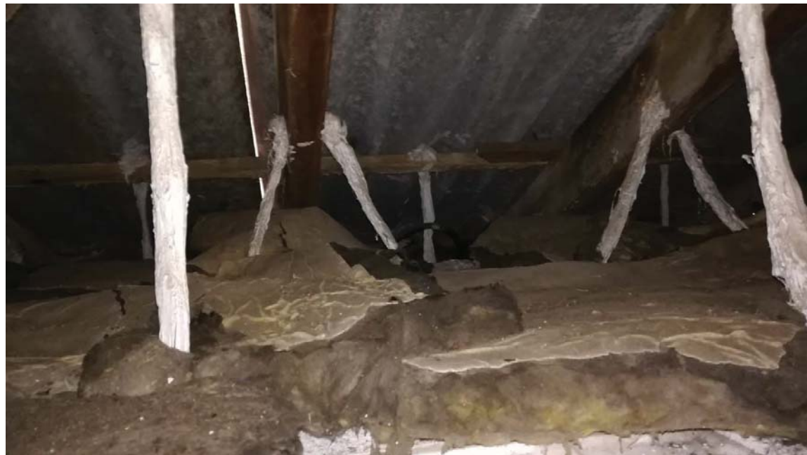
Fotografía 36. Vista general de la estructura de madera de la cubierta
