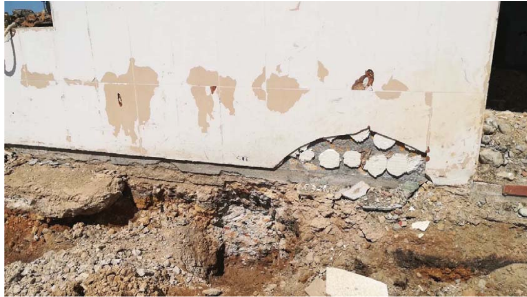
Cimiento fachada Este
