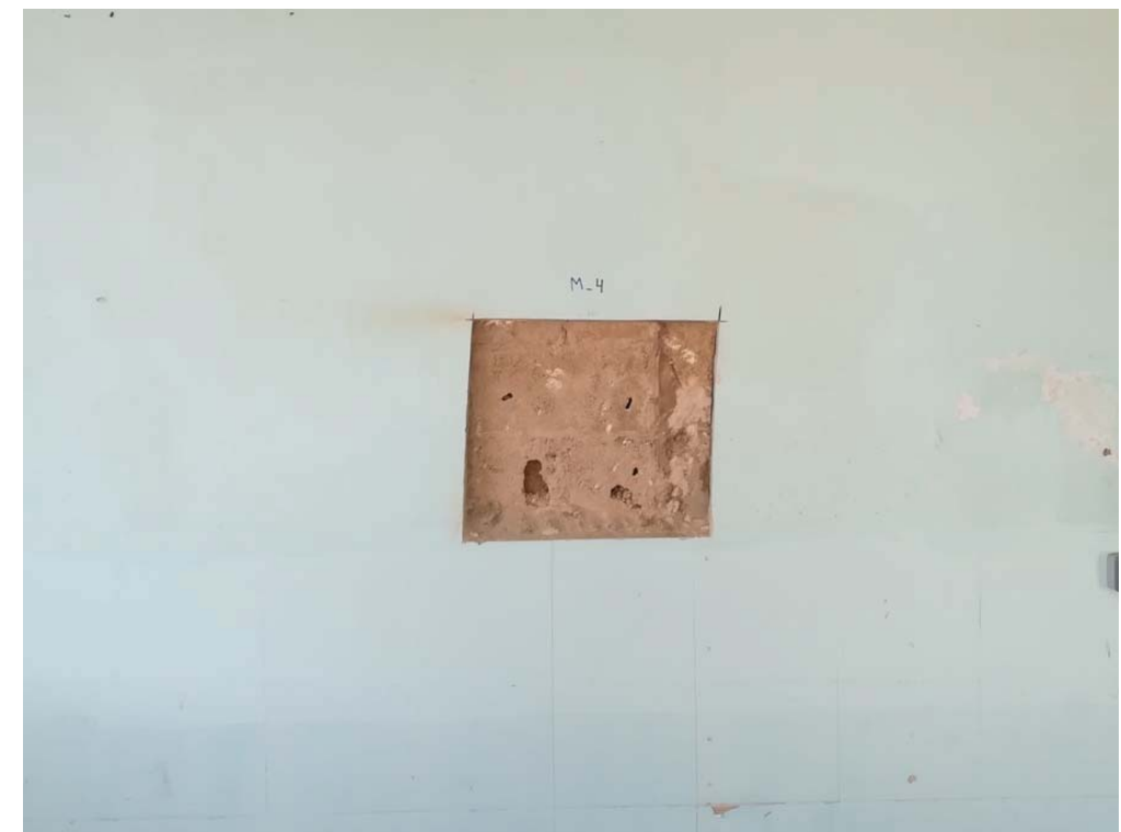
Fotografía 8. Vista general Cata M_4
