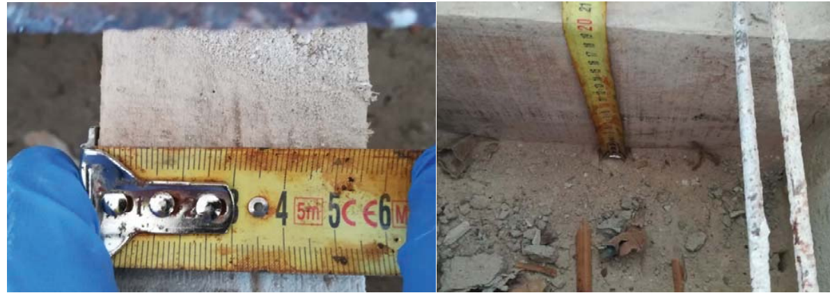
Fotografía 31. Medición de las viguetas de madera
