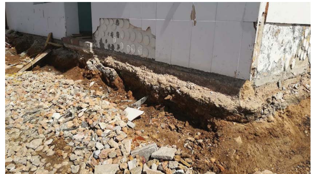
Cimiento fachada Sur
