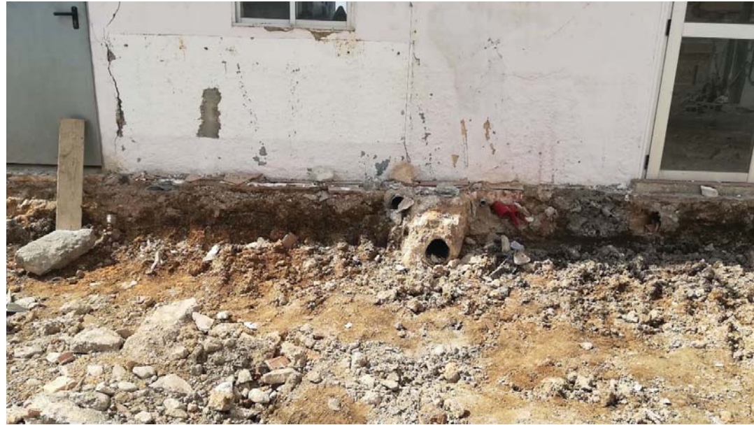
Cimiento fachada Norte
