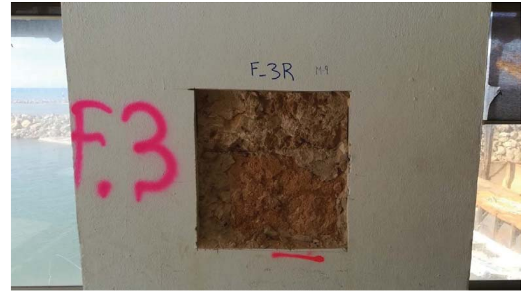
Fotografía 19. Vista general cata M_9 (F_3)
