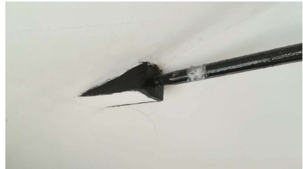
Fotografía 44. Detalle del anclaje de los tirantes metálicos
