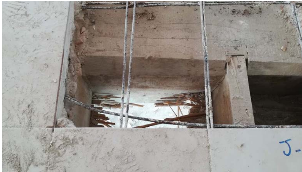
Fotografía 41. Retirada falso techo cañizo de la jácena, cata JI_1
