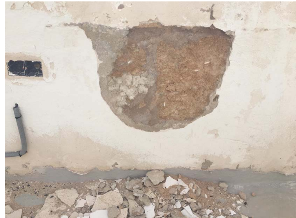
Fotografía 28. Vista detalle cata en torreón M_12b
