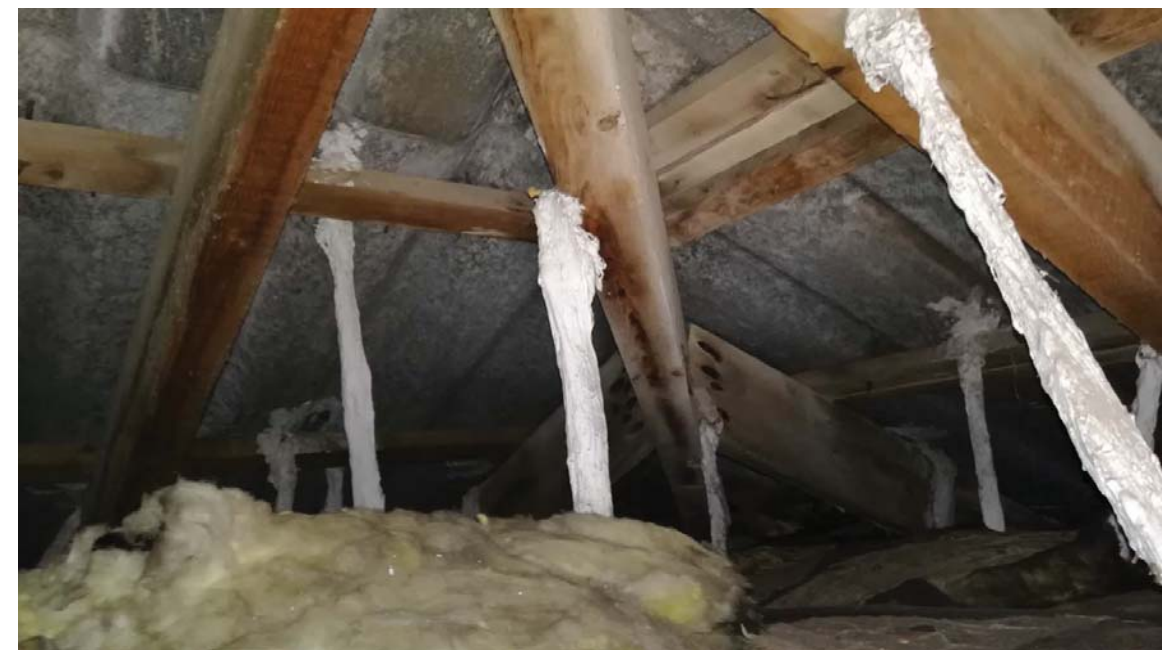
Fotografía 34. Vista general de la estructura de madera de la cubierta
