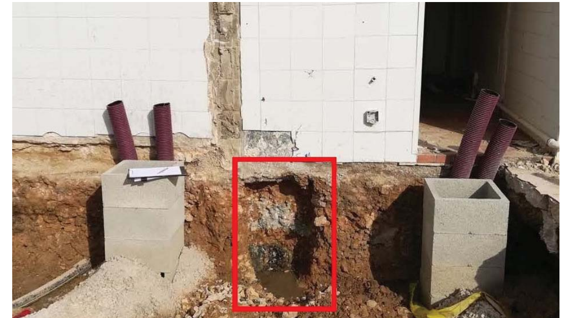
Fotografía 1. Cata realizada en la cimentación del edificio
