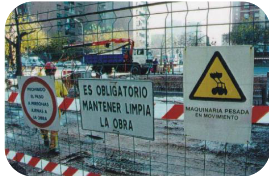
Señalización en zona de obras
