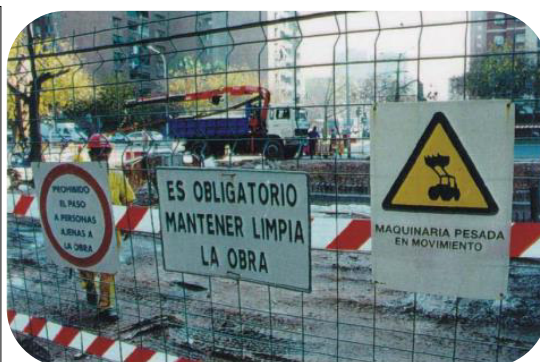
Señalización en zona de obras
