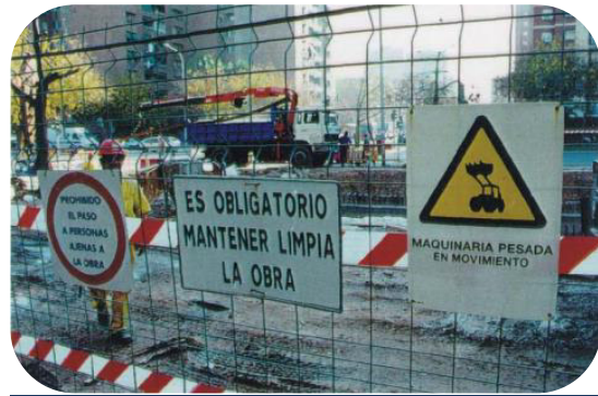
Señalización en zona de obras
