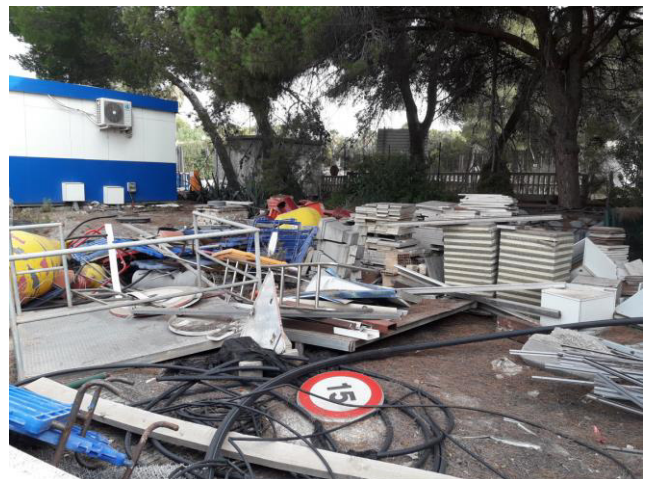
Imagen 24. Zona de acopio en M. Ribera
