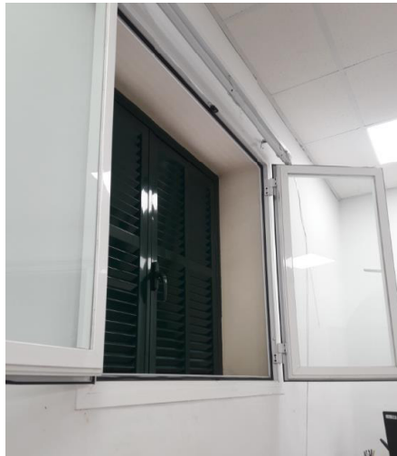
Imagen 15. Ventana edificio de oficinas de la APB
