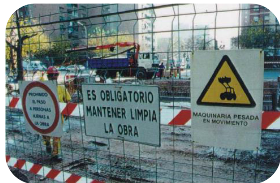
Señalización en zona de obras
