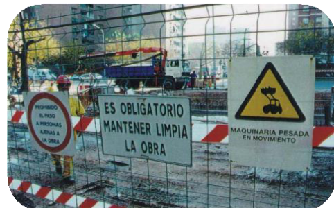
Ejemplo: señalización en zona de obras
