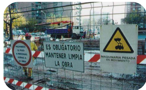
Ejemplo: señalización en zona de obras
