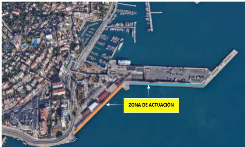
— LÍNEA DE DEFENSAS MUELLE DE PARAIREs — LÍNEA DE DEFENSAS AMPLIACIÓN MUELLE SUR
