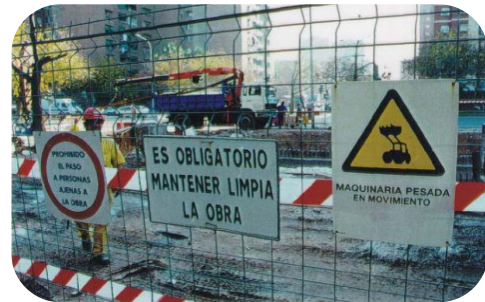
Ejemplo: señalización en zona de obras
