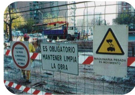
Ejemplo: señalización en zona de obras
