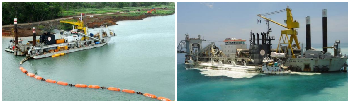
Figura 13. Sistema de vertido por tubería (izquierda) o mediante gánguil (derecha). Fuente: IADC
