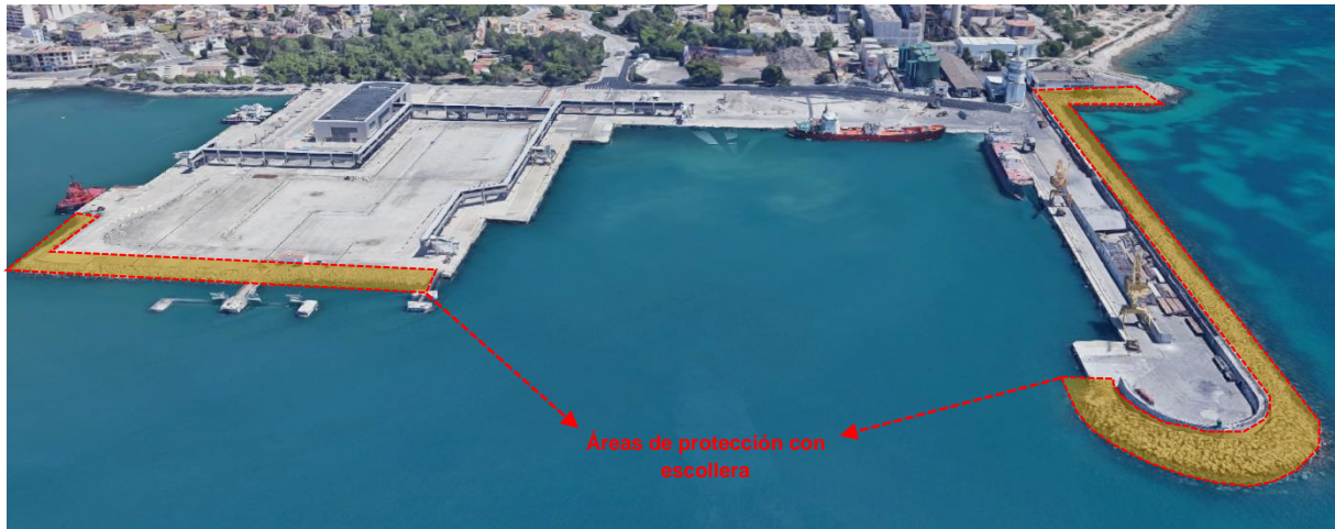
Figura 8. Imagen de la protección de escollera en el Puerto de Alcudia. Fuente: Elaboración propia
