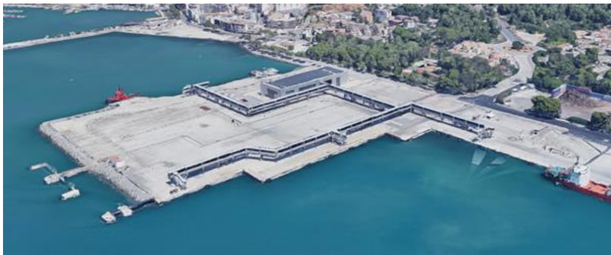
Figura 3. Imagen aérea de los Muelles de Poniente en el Puerto de Alcudia
