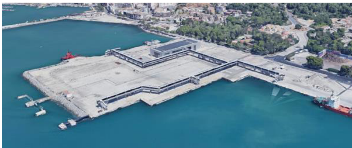
Figura 2. Imagen aérea de los Muelles de Poniente en el Puerto de Alcudia
