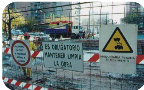
Ejemplo: señalización en zona de obras
