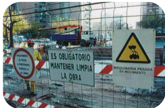
Señalización en zona de obras
