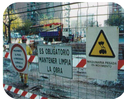
Ejemplo: señalización en zona de obras
