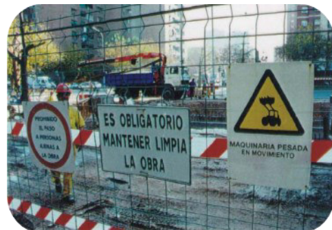
Ejemplo: señalización en zona de obras
