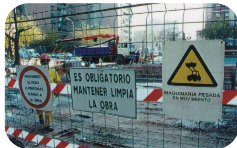
Ejemplo: señalización en zona de obras
