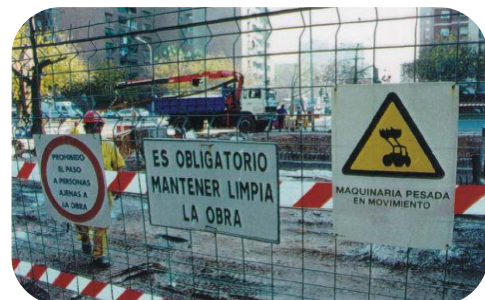
Ejemplo: señalización en zona de obras
