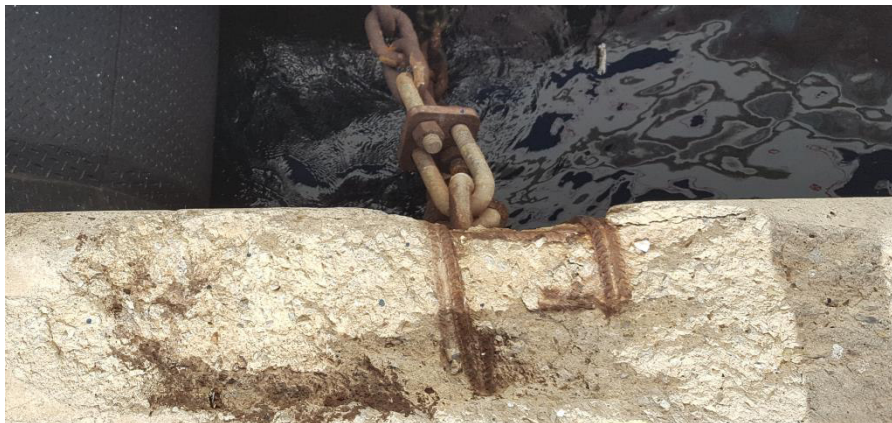
Anclaje de cadena y perno lateral en la defensa nº 8
