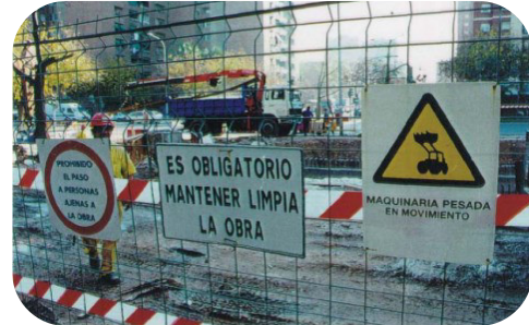
Ejemplo: señalización en zona de obras
