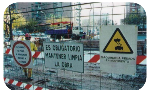
Ejemplo: señalización en zona de obras
