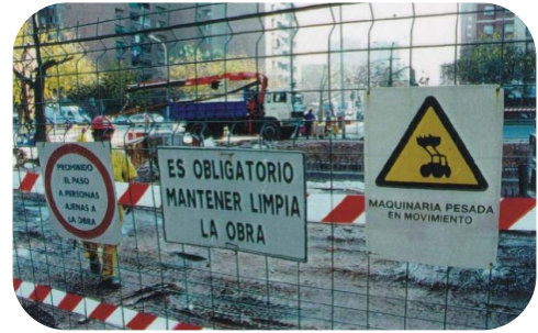
Ejemplo: señalización en zona de obras
