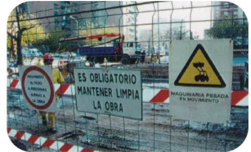
Ejemplo: señalización en zona de obras
