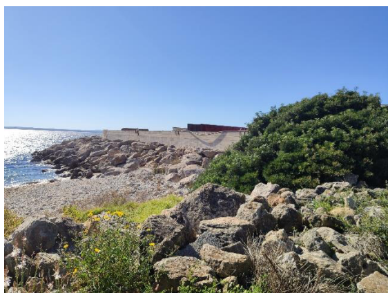
Muro exterior zona T.M.A
