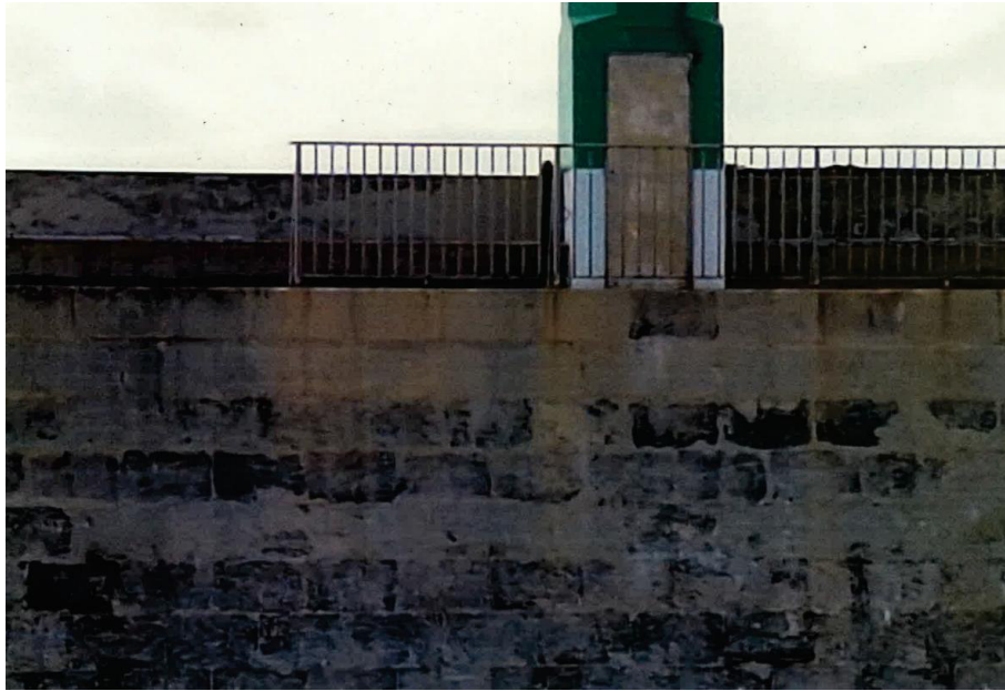
Figura 5. Estado actual del dique de abrigo Muelle Adosado
