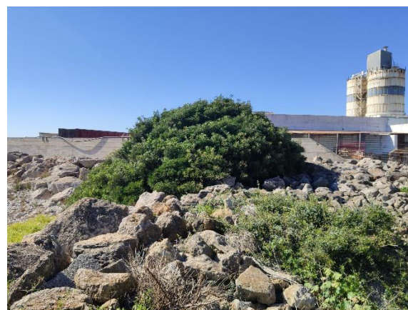
Muro exterior zona T.M.A
