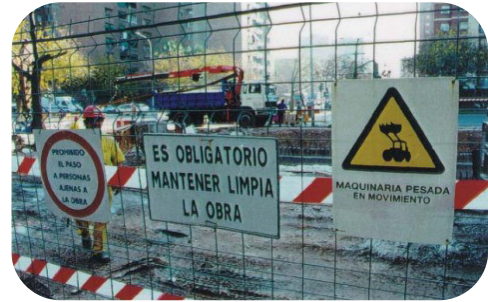
Ejemplo: señalización en zona de obras
