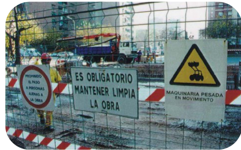
Ejemplo: señalización en zona de obras
