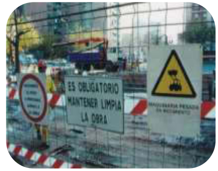
Ejemplo: señalización en zona de obras
