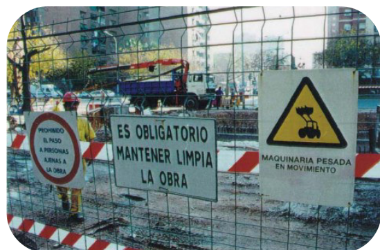
Señalización en zona de obras
