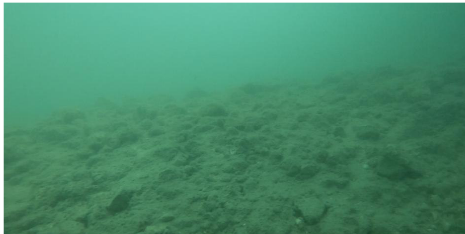
Ilustración 3. Piedra machaca encima de bloques de guarda (3ª alineación)
