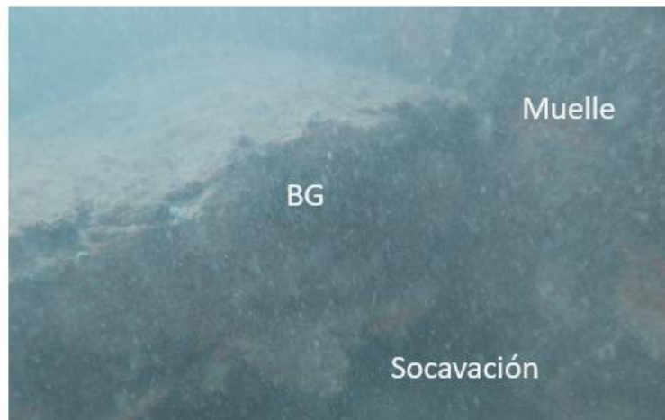
Ilustración 6. Imágenes del estado actual de la 2ª alineación en la zona de amarre de proa/popa
