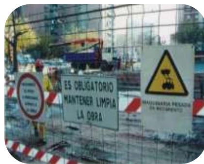
Ejemplo: señalización en zona de obras
