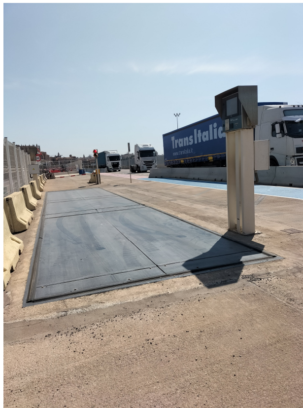
Estado actual de la zona de implantación de la nueva báscula.
