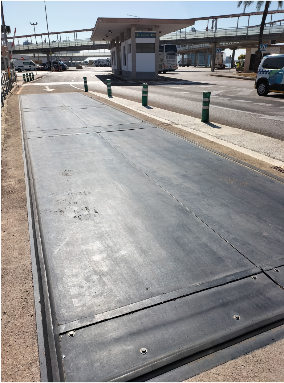
Sistema de pesado de la bàscula de salida a M. de Poniente
