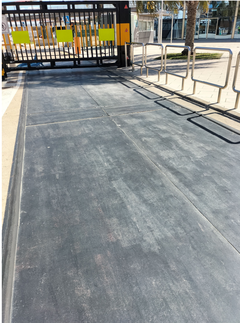
Sistema de pesado de la bàscula de entrada a M. de Poniente
