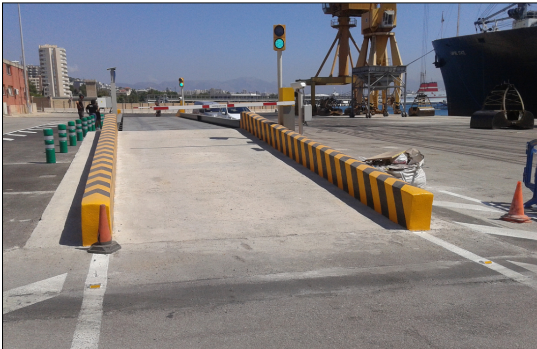
Estado actual de la báscula
