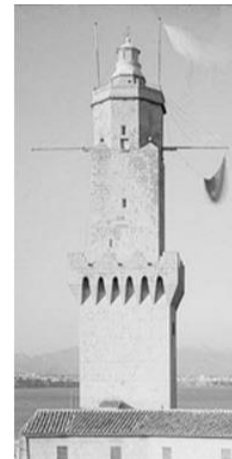
1926. Fotografía antes de la obra
