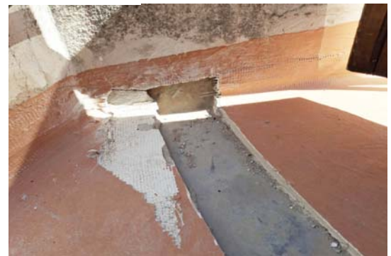
Reposición de la impermeabilización superior: mortero malla FV y pintura de caucho
