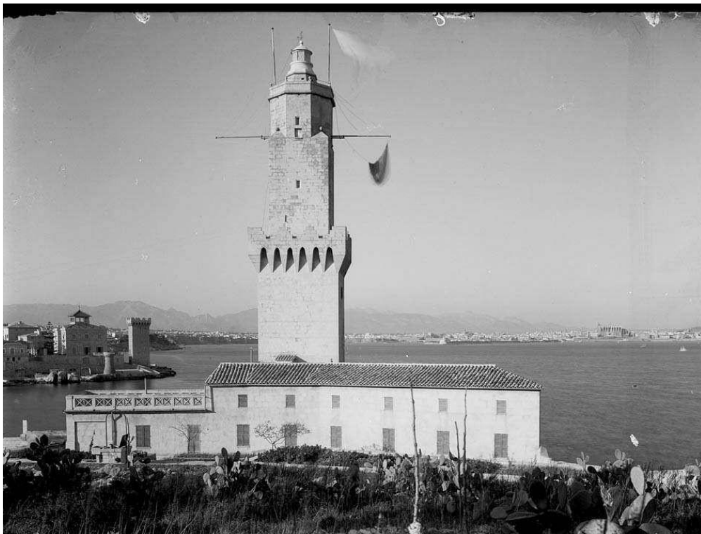
Vista de la Torre de Señales antes de la ejecución del proyecto de 1926.
