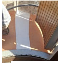
Reposición de la impermeabilización superior: mortero malla FV y pintura de caucho
