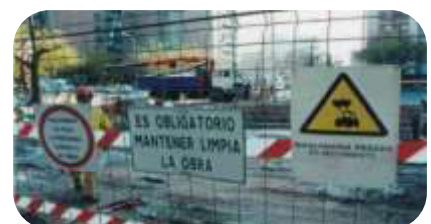
Ejemplo: señalización en zona de obras
