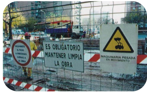
Ejemplo: señalización en zona de obras
