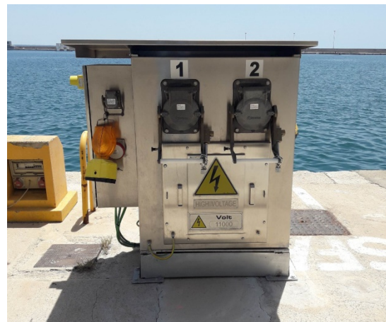
Centro de Transformación y Subestación OPS
