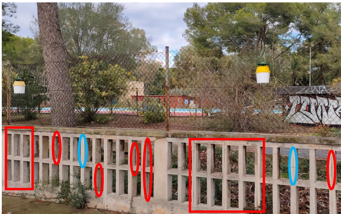
Figura 3.- Lateral sur, zona restringida pasado la Estación Marítima.
