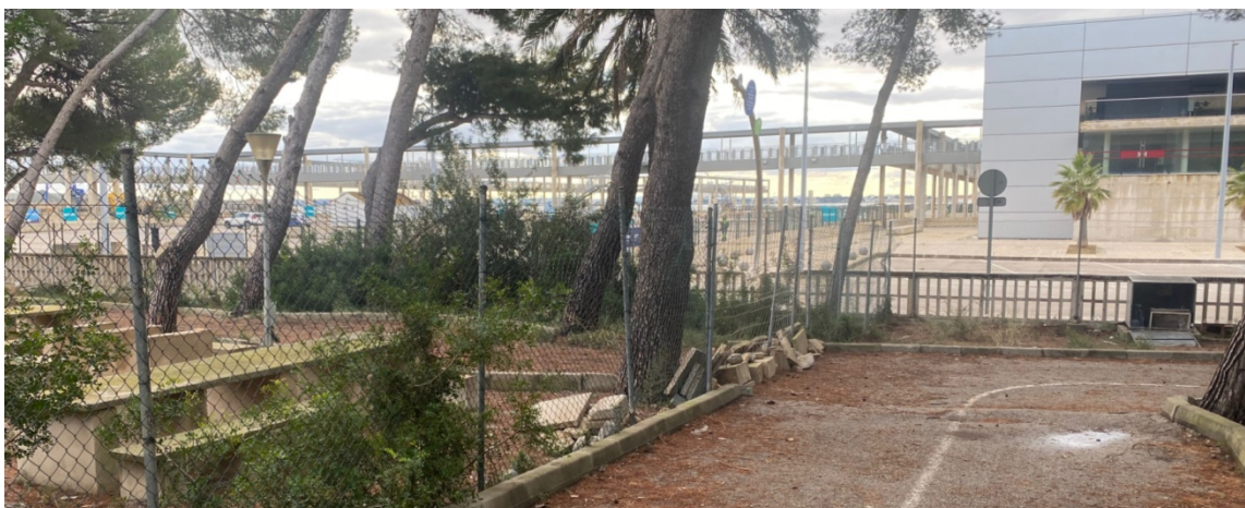
Figura 17.- Escombros en la zona de merendero, dentro de la zona de la piscina con vallado intermedio simple.
