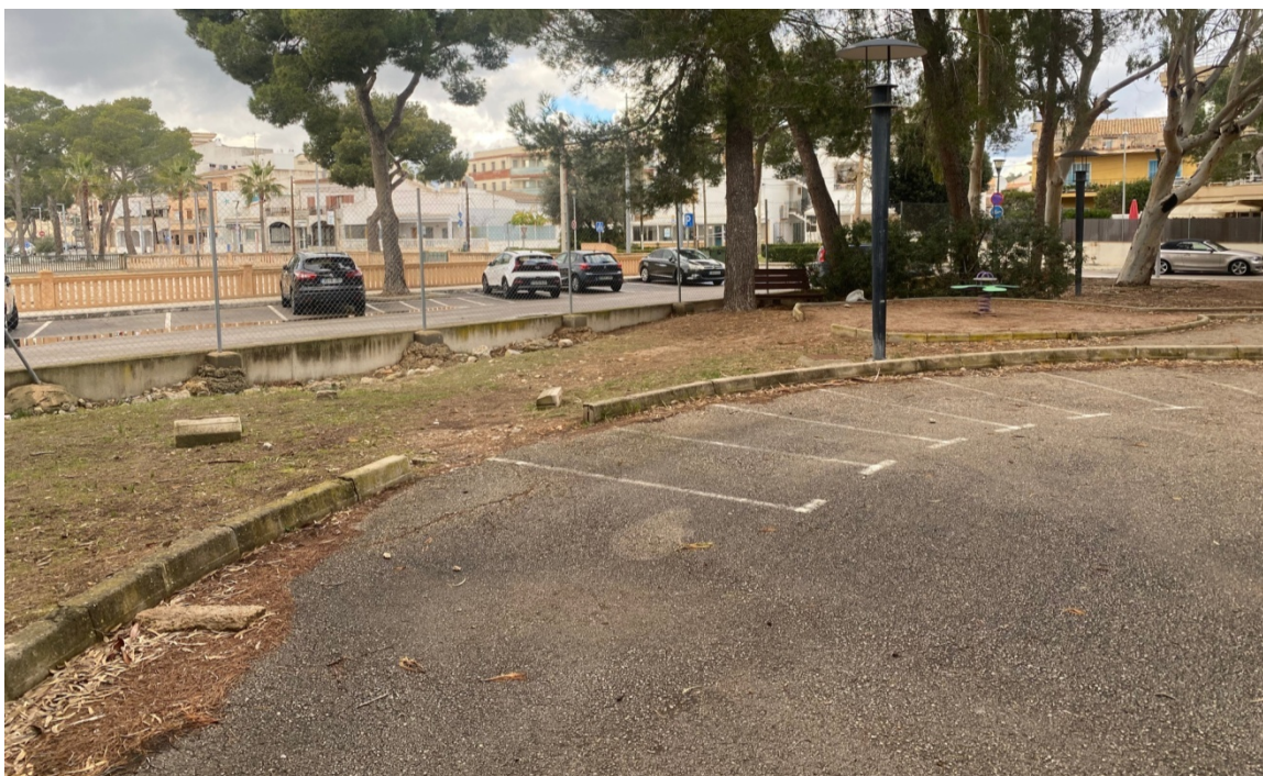
Figura 18.- Rotonda interior anexa a área infantil con reposición de bordillo y limpieza de escombros junto a mazacotas de los postes del vallado.
