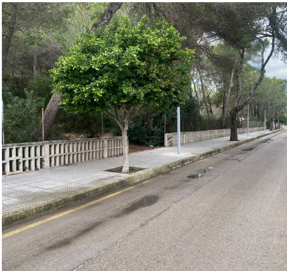
Figura 14.- Árbol ladeado y podado de ramas para evitar hojas sobre calzada. Acceso al parque por apertura de muro. Desconsolidación de zanja histórica sobre asfalto (fuera del ámbito del proyecto).
