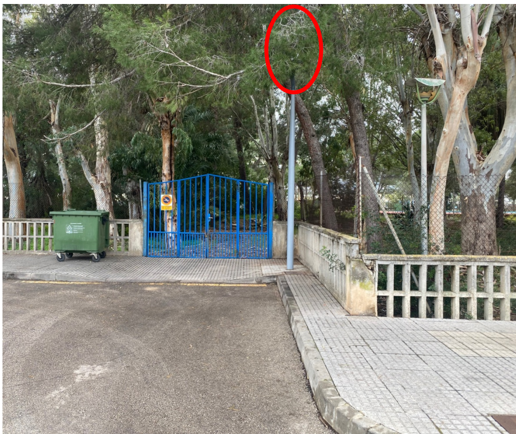
Figura 12.- Lateral norte. Acceso por camino interior (con mucha hoja suelta) encintado con bordillo delimitador de parterres. Ramas a podar sobre farola en acera.
