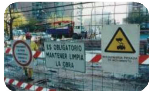
Ejemplo: señalización en zona de obras
