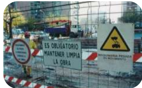
Ejemplo: señalización en zona de obras
