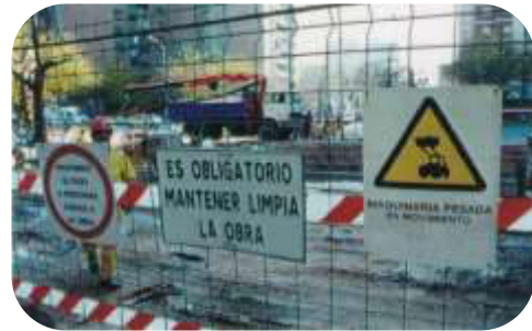
Ejemplo: señalización en zona de obras
