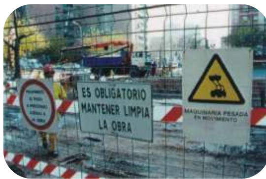
Señalización en zona de obras
