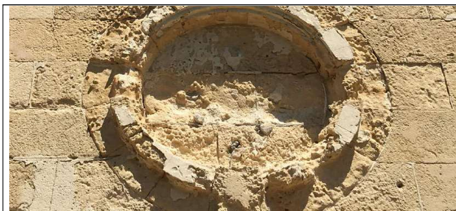
Piezas de la zona inferior del rosetón afectada por arenización
