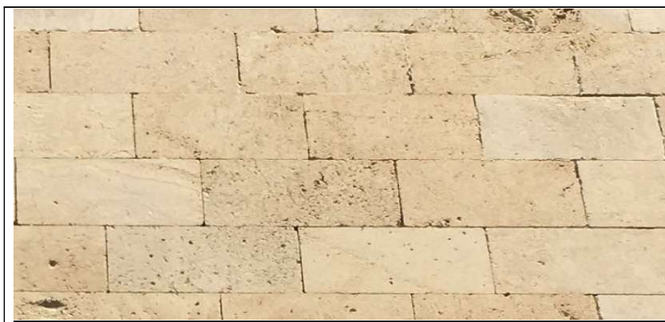
Zonas de vaciado de juntas del aplacado
