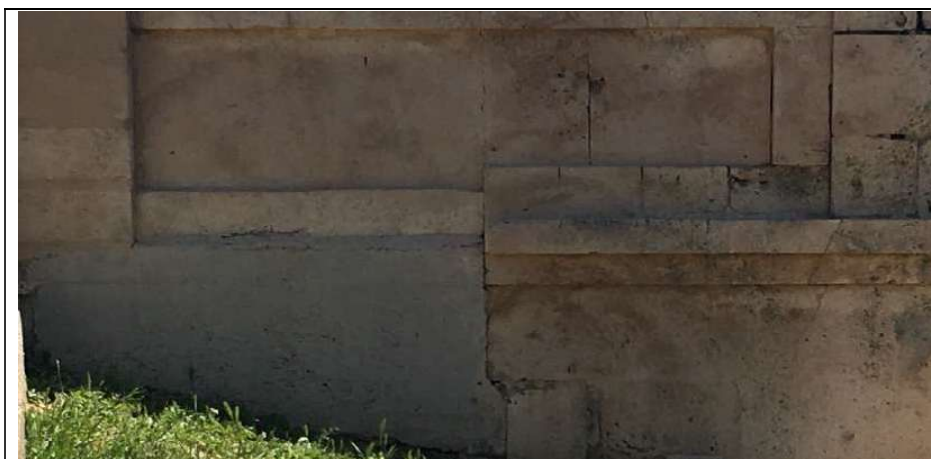
Muro de hormigón en la parte inferior izquierda
