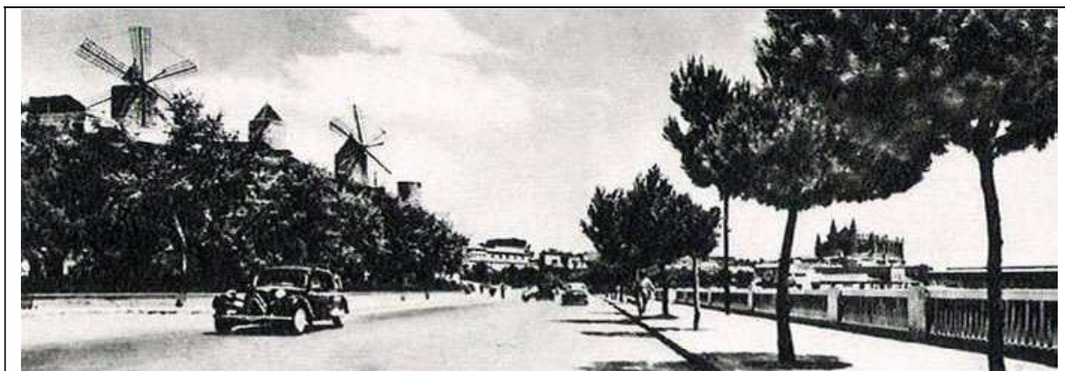
Fotografía del talud con la construcción del Paseo Marítimo en 1949
