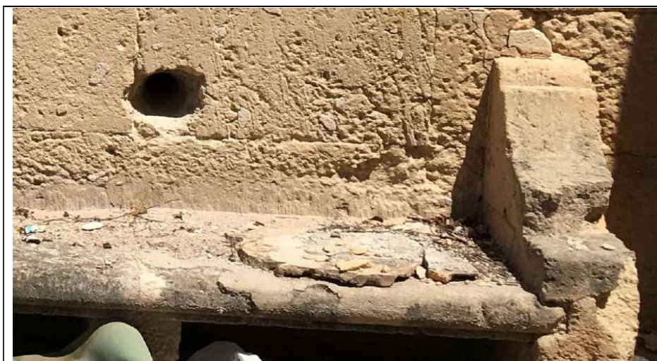
Fragmentación del remate lateral del banco
