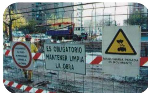
Ejemplo: señalización en zona de obras
