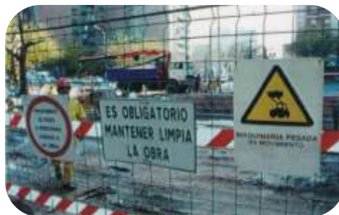
Ejemplo: señalización en zona de obras
