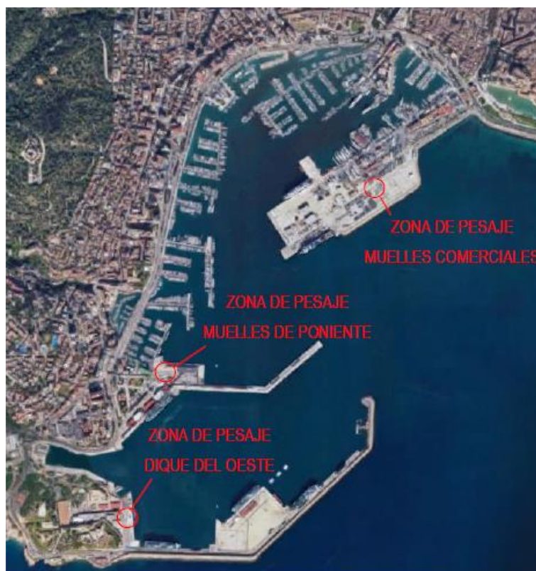
Imagen 1: Ubicación de los elementos de pesaje
