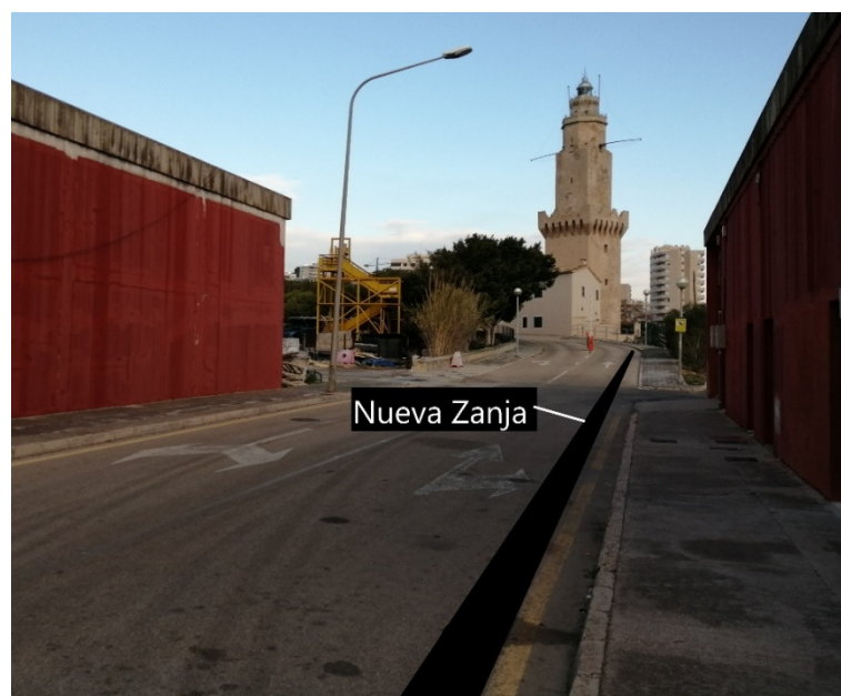
Ilustración 4. Nueva zanja desde la intersección con la canalización de la cámara hasta la altura del control de acceso, a realizar por la calzada .
