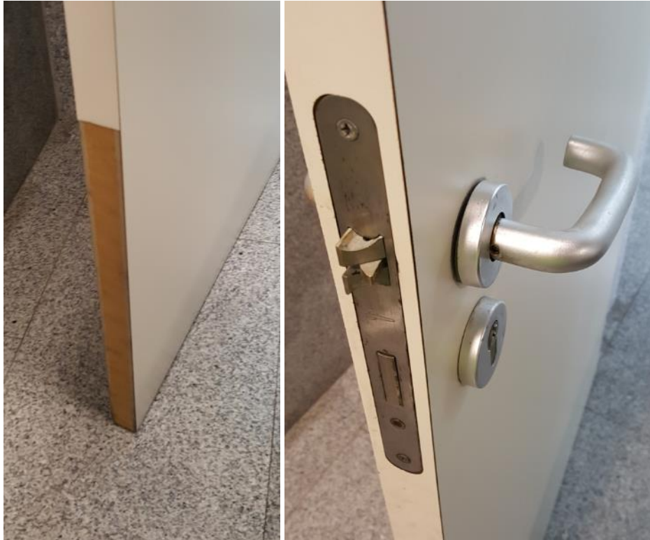
Fotografías 89,90. Baño Estación Marítima 3, Zona Planta baja – Embarque (Hombres). Detalle de puerta principal
