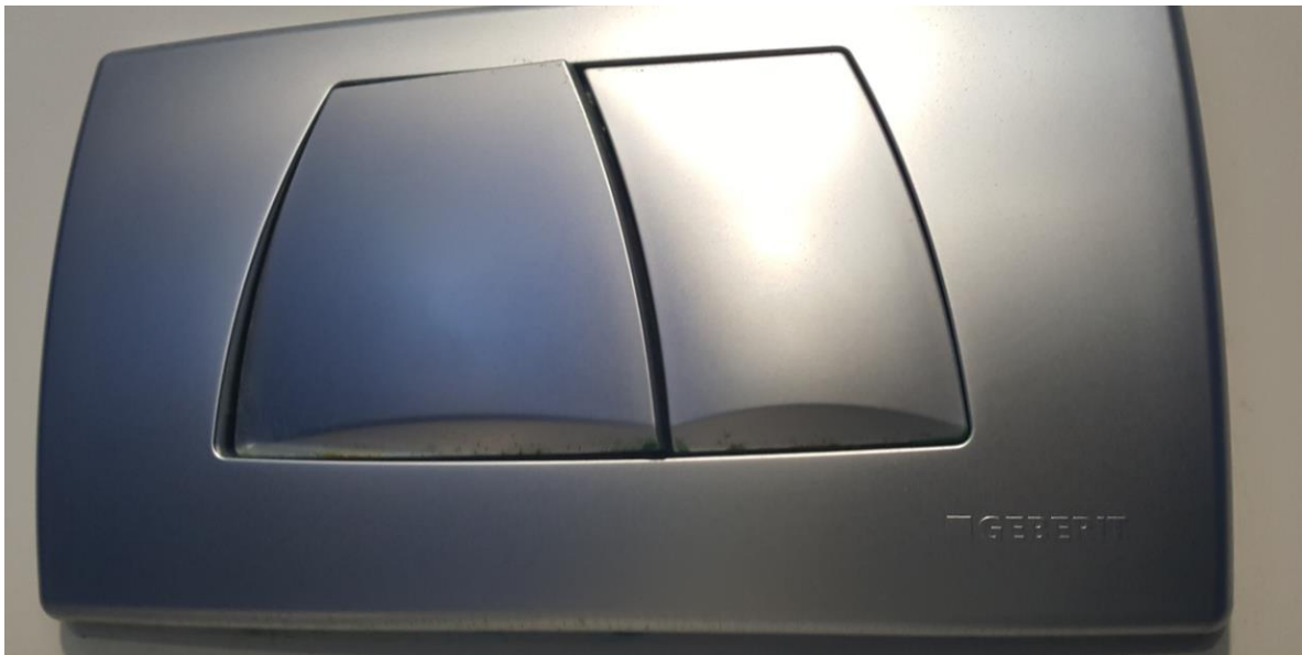
Fotografía 64. Baño Estación Marítima 2, Zona Planta entresuelo – Duty Free (Mujeres). Cisterna con zonas verdosas y puntos de impulso de agua movidos.
