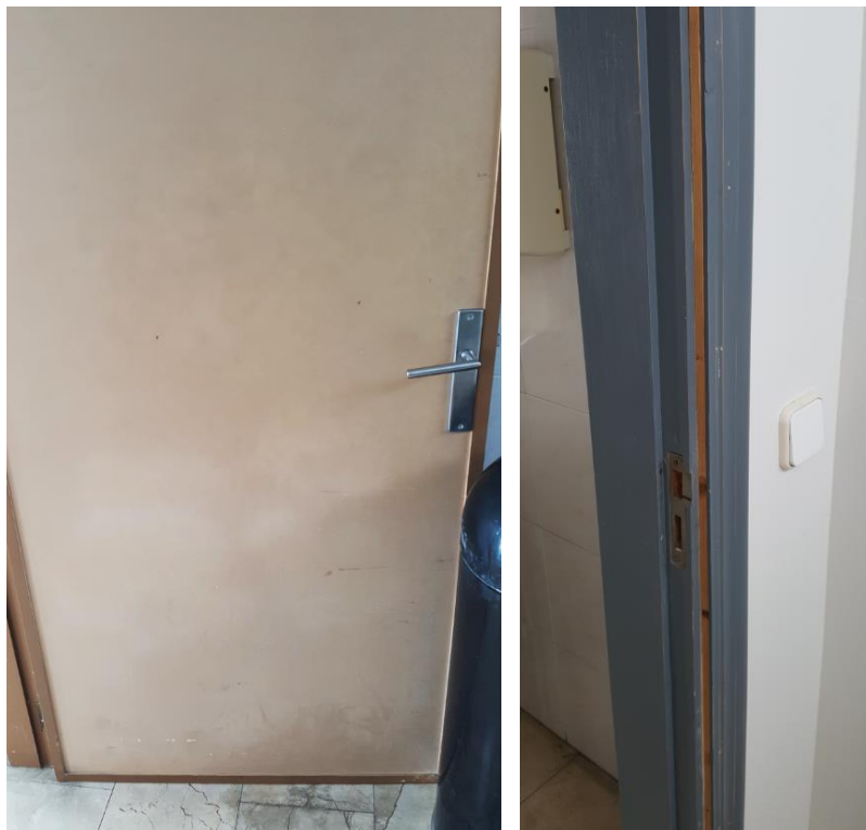
Fotografías 150, 151. Baño Estación Marítima 5, Baños planta baja – Mujeres. Detalle de puertas
