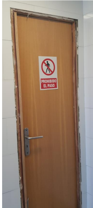
Fotografía 19. Baño Estación Marítima 2, Zona Planta baja – Cafetería, Caballeros. Detalle de marco de puerta en cuarto de limpieza, dentro del baño.
