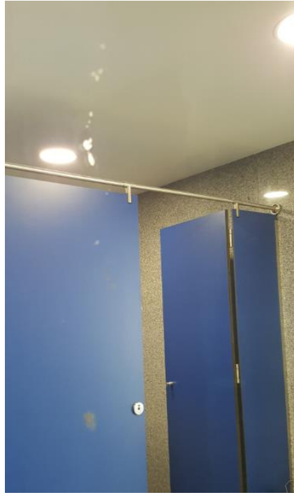
Fotografía 117. Baño Estación Marítima 3, Zona Planta alta – Embarque (Mujeres). Detalle de desgaste en espejo
