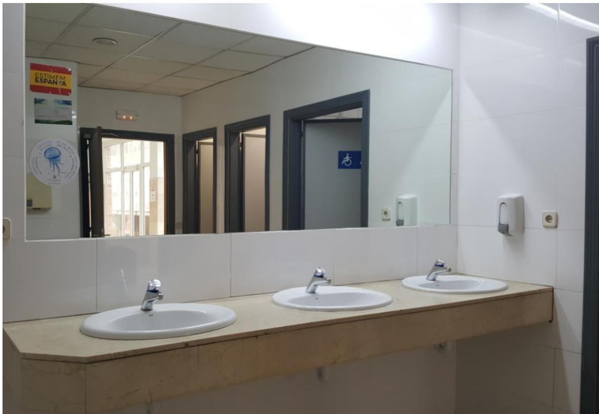
Fotografía 135. Baño Estación Marítima 5, Baños planta baja – Hombres. Detalle de encimera de baño y pegatinas en espejos
