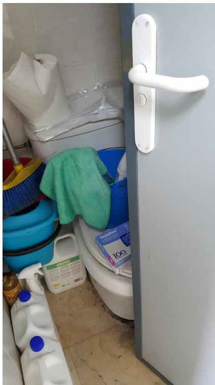
Fotografía 162. Baño Estación Marítima 5, Baños planta alta – Mujeres. Tercer cuarto de baño individual, al que no se puede acceder por roce de puerta con inodoro. Se usa como zona de acopio de material de limpieza
