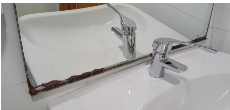
Fotografías 75, 76. Baño Estación Marítima 3, Zona Planta baja – Hall (Hombres). Detalles de espejos.
