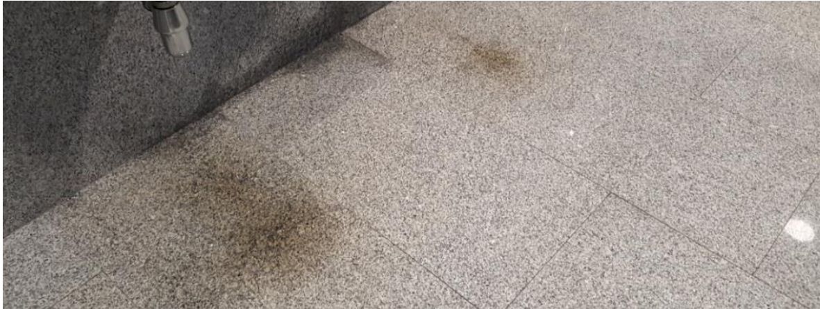
Fotografía 115. Baño Estación Marítima 3, Zona Planta alta – Embarque (Hombres). Detalle de suelos
