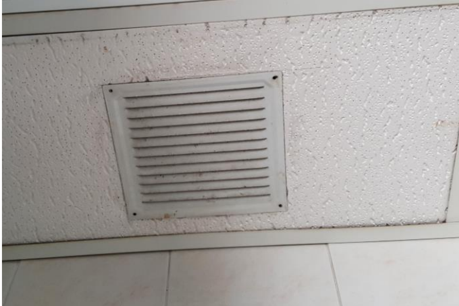
Fotografías 167. Baño Estación Marítima 5, Baños planta alta – Mujeres. Detalle de rejillas y placas techo
