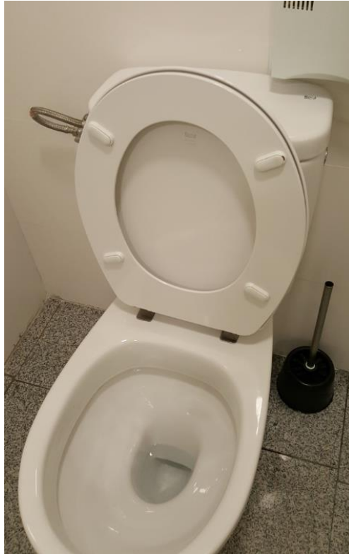
Fotografía 81. Baño Estación Marítima 3, Zona Planta baja – Hall (Mujeres). Detalle de tapa inodoro
