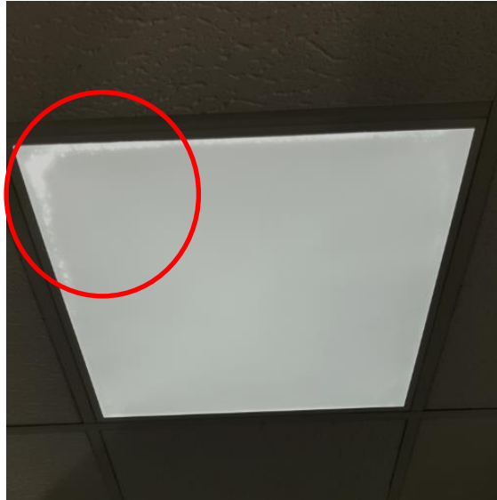
Fotografía 164. Baño Estación Marítima 5, Baños planta alta – Mujeres. Detalle de techo y placas de luz
