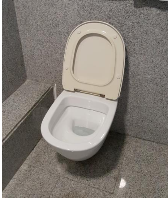
Fotografía 111. Baño Estación Marítima 3, Zona Planta alta – Embarque (Hombres). Detalle de tapa amarillenta en inodoro
