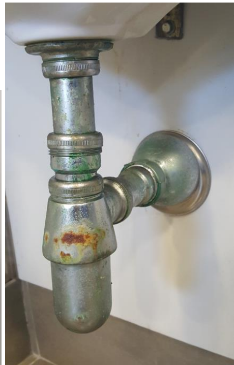
Fotografías 50, 51. Baño Estación Marítima 2, Zona Planta entresuelo – Duty Free. Signos de oxidación.
