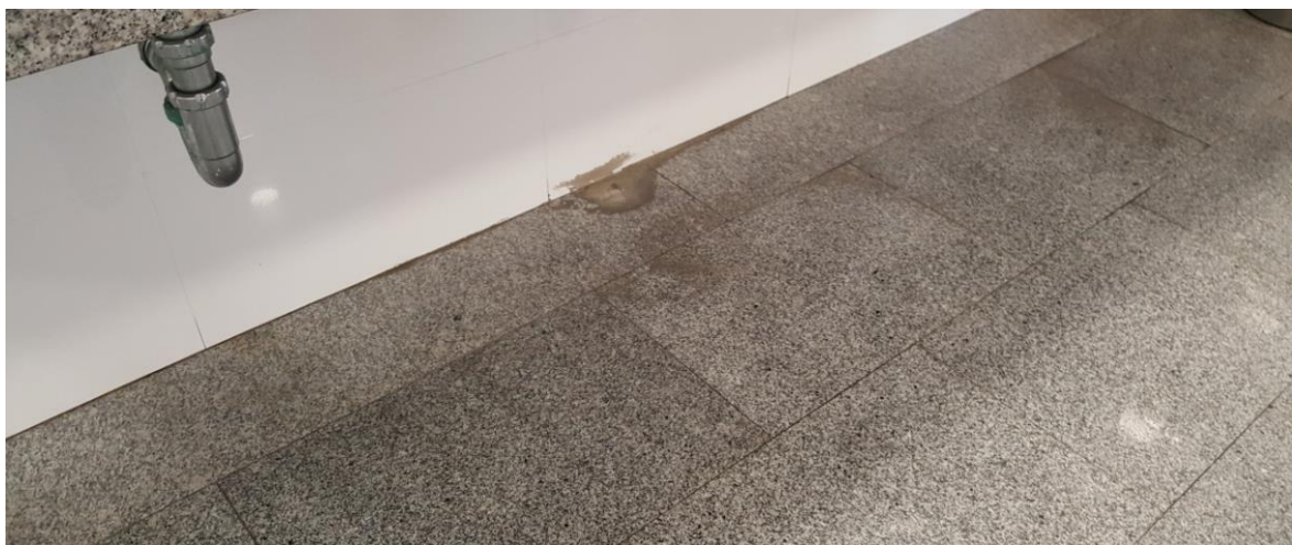
Fotografías 79. Baño Estación Marítima 3, Zona Planta baja – Hall (Hombres). Detalles en suelos
