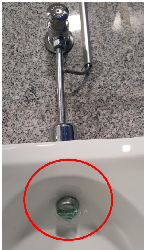
Fotografía 86. Baño Estación Marítima 3, Zona Planta baja – Embarque (Hombres). Detalles de urinarios
