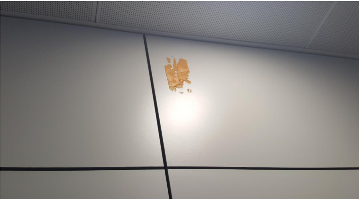
Fotografía 26. Baño Estación Marítima 2, Zona Planta baja – Cafetería, Mujeres. Detalle en revestimiento gris de pared.
