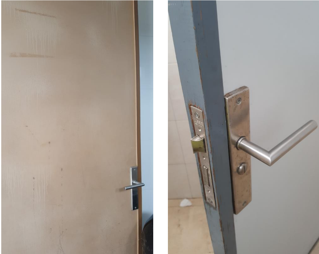
Fotografías 141, 142. Baño Estación Marítima 5, Baños planta baja – Hombres. Detalle de puerta principal, color marrón, y puertas baños individuales, color gris. Desgastadas, sin cartel de “Hombres”. Envejecidas.
