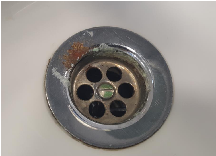
Fotografías 50, 51. Baño Estación Marítima 2, Zona Planta entresuelo – Duty Free. Signos de oxidación.
