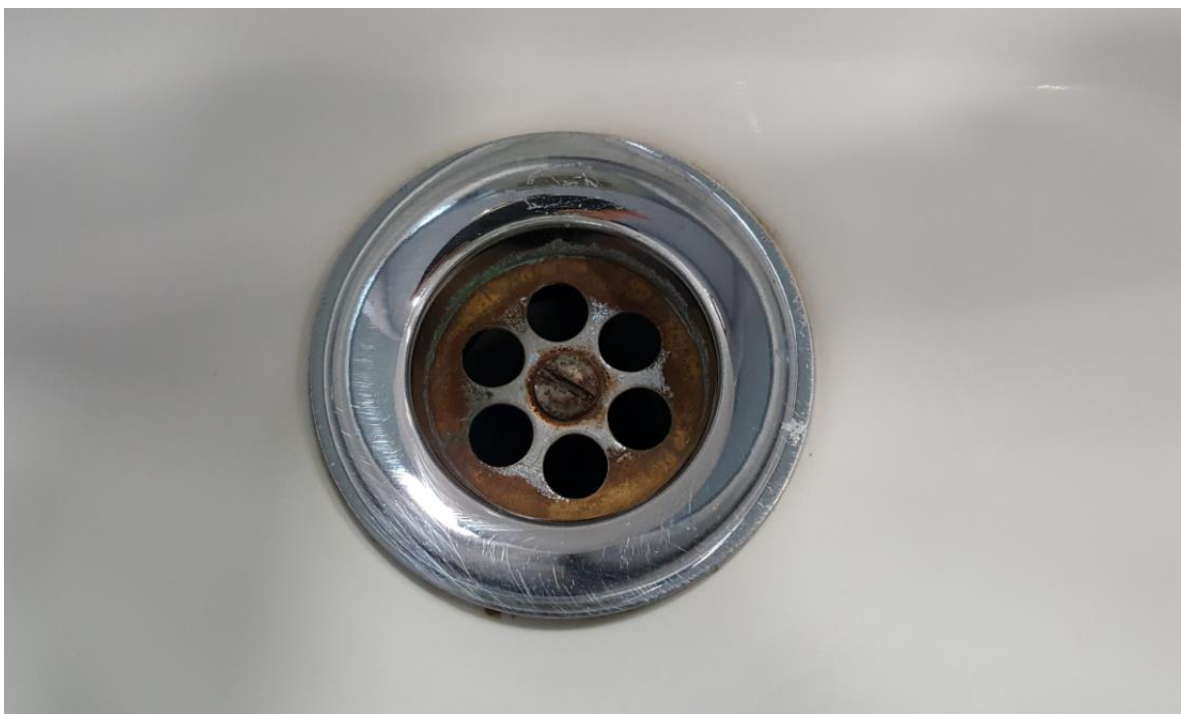
Fotografía 116. Baño Estación Marítima 3, Zona Planta alta – Embarque (Mujeres). Detalle de grifería
