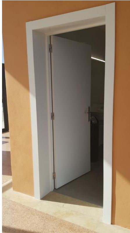
Fotografía 5. Baño Estación Marítima 1, Zona Duty Free, Caballeros y Señoras. Falta de letreros que designen si son baños de caballeros o de señoras.
