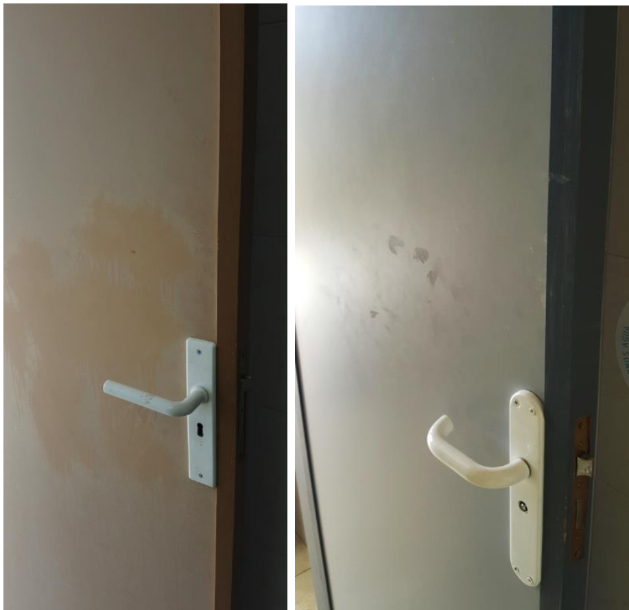
Fotografías 165, 166. Baño Estación Marítima 5, Baños planta alta – Mujeres. Detalle de puertas
