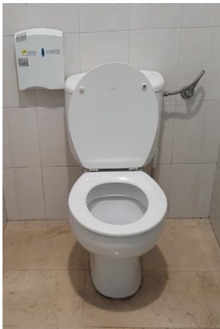
Fotografía 136. Baño Estación Marítima 5, Baños planta baja – Hombres. Detalle de tapas de inodoros
