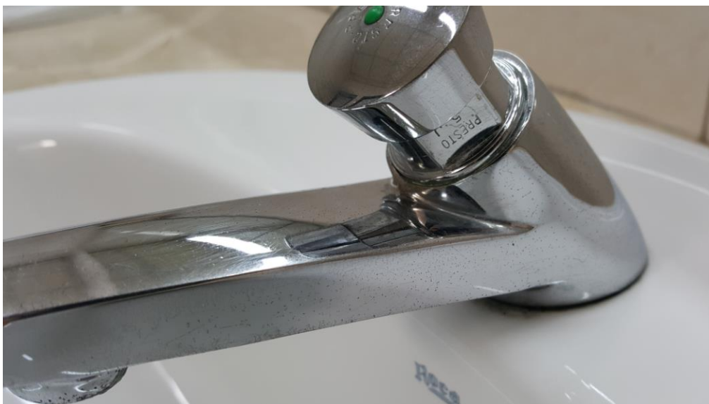
Fotografías 143. Baño Estación Marítima 5, Baños planta baja – Mujeres. Detalle de grifería picada
