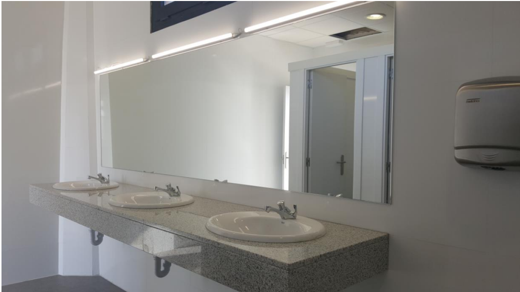
Fotografía 1. Baño Estación Marítima 1, Zona Duty Free, Caballeros. Vista general (falta de jaboneras y cambiadores de bebé)
