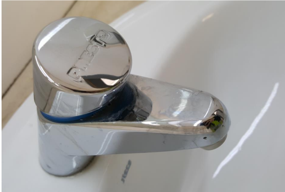
Fotografía 134. Baño Estación Marítima 5, Baños planta baja – Hombres. Detalle de grifería
