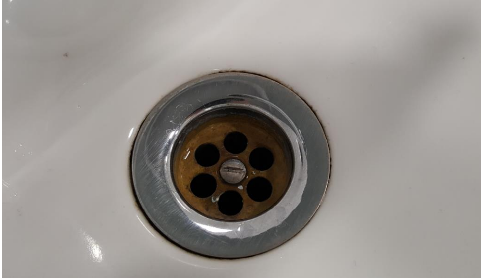
Fotografía 97. Baño Estación Marítima 3, Zona Planta alta – Terraza (Hombres). Detalle de grifería
