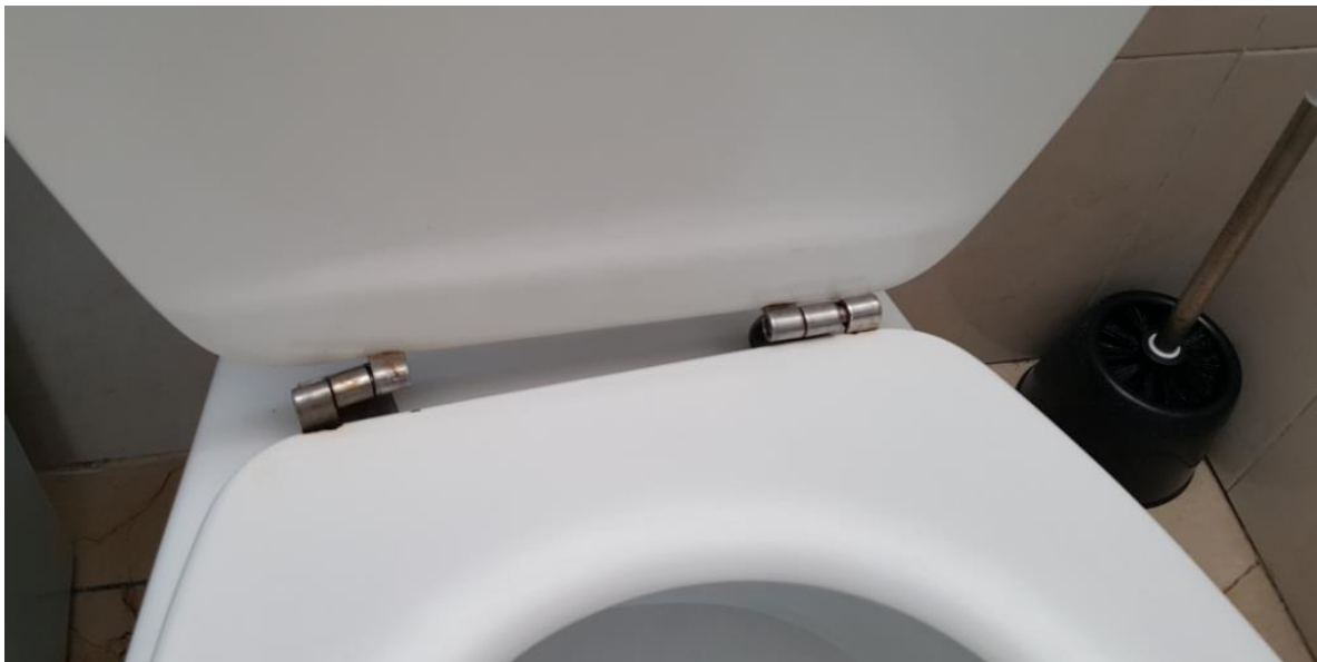
Fotografías 145. Baño Estación Marítima 5, Baños planta baja – Mujeres. Detalle de inodoros
