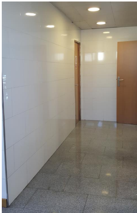
Fotografía 22. Baño Estación Marítima 2, Zona Planta baja – Cafetería, Caballeros. Espacio disponible para cambiador de bebés.
