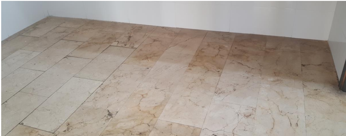
Fotografía 140. Baño Estación Marítima 5, Baños planta baja – Hombres. Detalle de suelos
