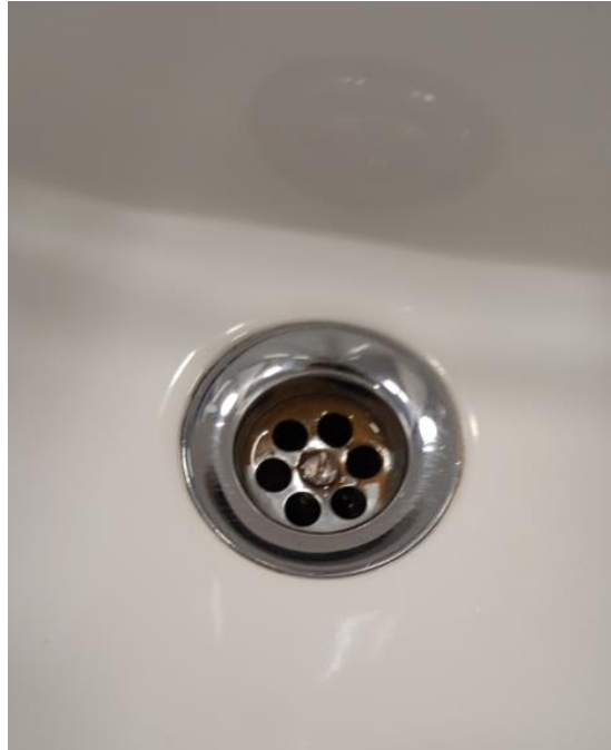
Fotografía 72. Baño Estación Marítima 3, Zona Planta baja – Hall (Hombres). Detalle de grifería
