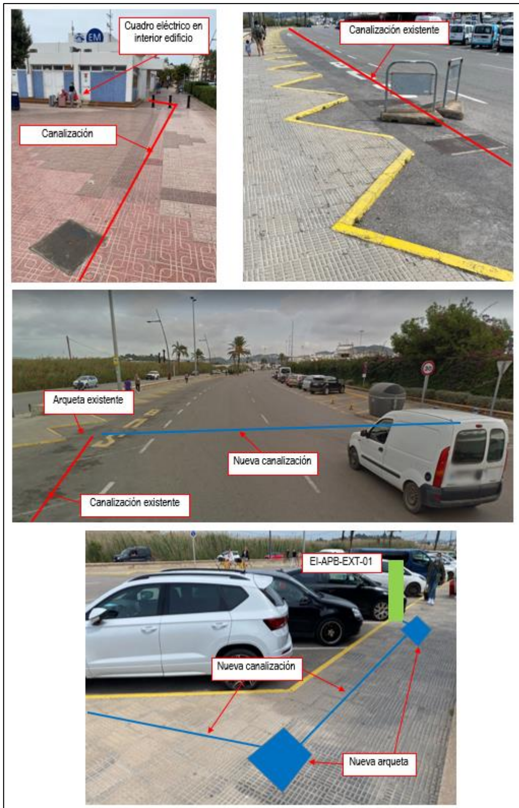
Ilustración 13. Detalle infraestructuras punto de recarga EI-APB-EXT-01 (solo APB) Club Náutico Eivissa
