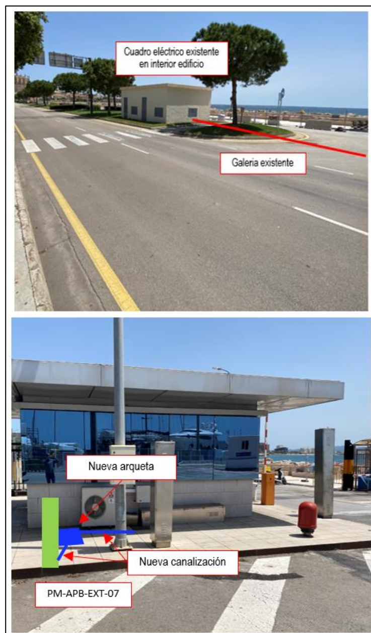
Ilustración 36. Detalle infraestructuras punto de recarga PM-APB-EXT-07 Muelles Comerciales Palma
