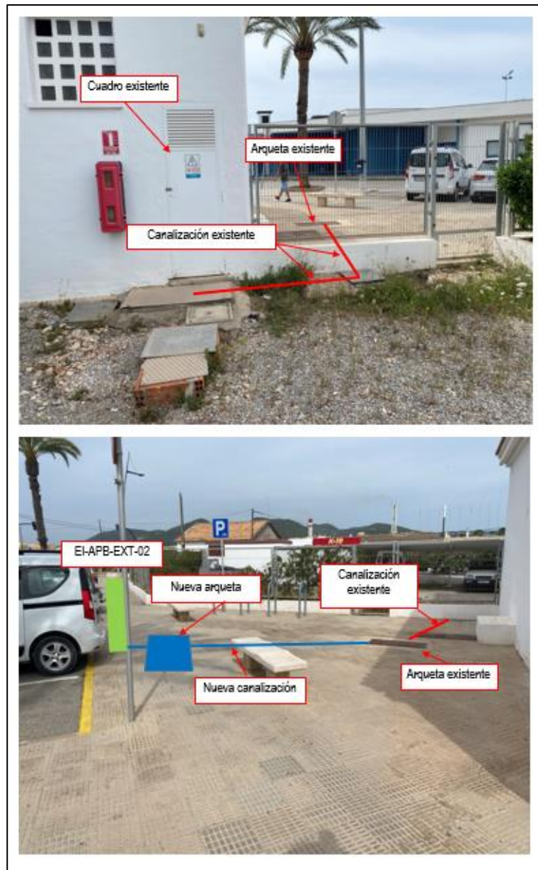
Ilustración 15. Detalle infraestructuras punto de recarga EI-APB-EXT-02 Oficinas APB Eivissa
