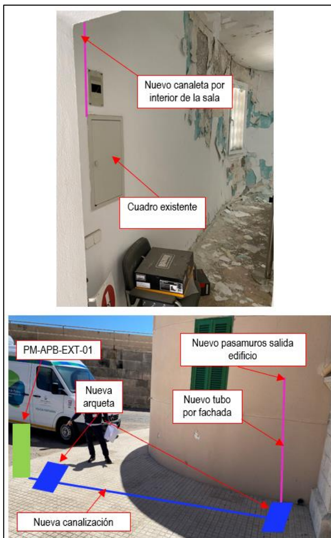
Ilustración 22. Detalle infraestructuras punto de recarga PM-APB-EXT-01 Dique Oeste Palma
