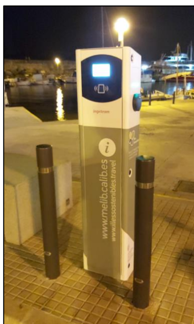
Ilustración 7. Ejemplo de protección de poste de recarga
