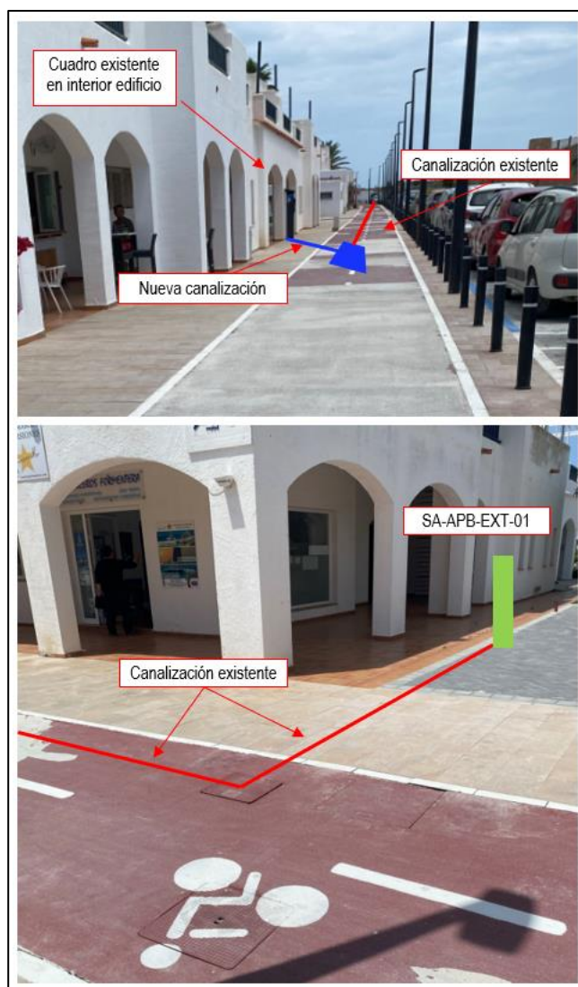
Ilustración 45. Detalle infraestructuras punto de recarga SA-APB-EXT-01 Nuevas oficinas APB La Savina.
