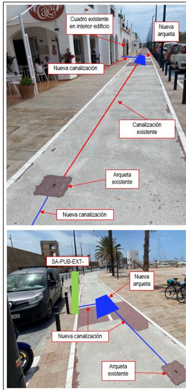
Ilustración 44. Detalle infraestructuras punto de recarga SA-PUB-EXT-01 Nuevas oficinas APB La Savina.
