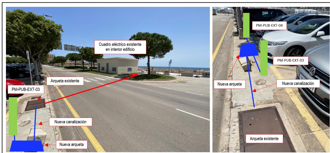
Ilustración 34. Detalle infraestructuras punto de recarga PM-PUB-EXT-03 y PM-PUB-EXT-04 Muelles Comerciales Palma
