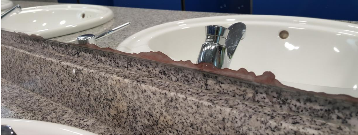
Fotografía 93. Baño Estación Marítima 3, Zona Planta baja – Embarque (Mujeres). Detalle de espejos
