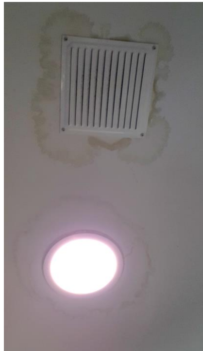
Fotografía 114. Baño Estación Marítima 3, Zona Planta alta – Embarque (Hombres). Detalle de techos
