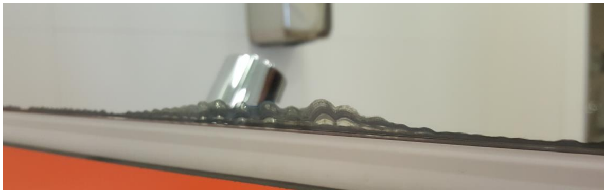
Fotografía 132. Baño Estación Marítima 4, Baños planta alta – Hombres. Detalle de espejo
