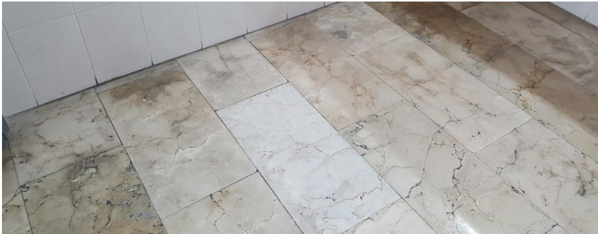
Fotografías 149. Baño Estación Marítima 5, Baños planta baja – Mujeres. Detalle de suelos
