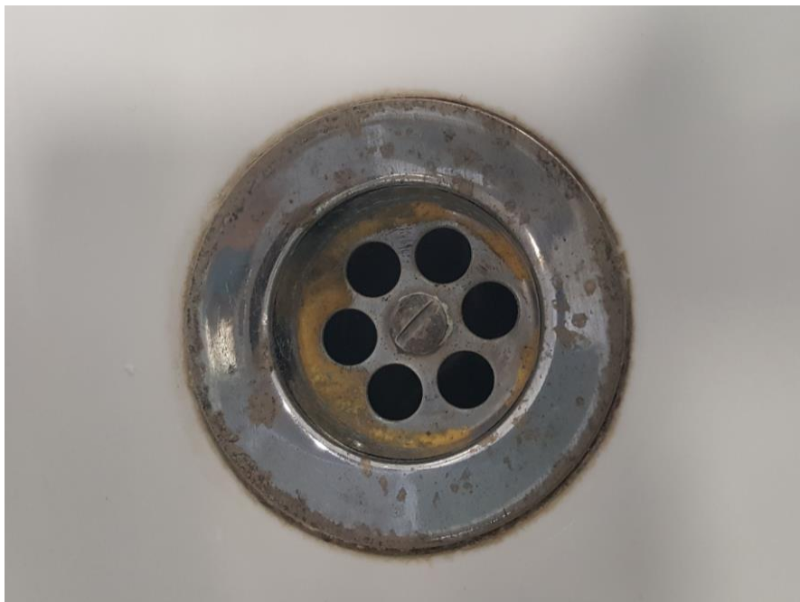
Fotografía 59. Baño Estación Marítima 2, Zona Planta entresuelo – Duty Free (Mujeres). Detalle de grifería
