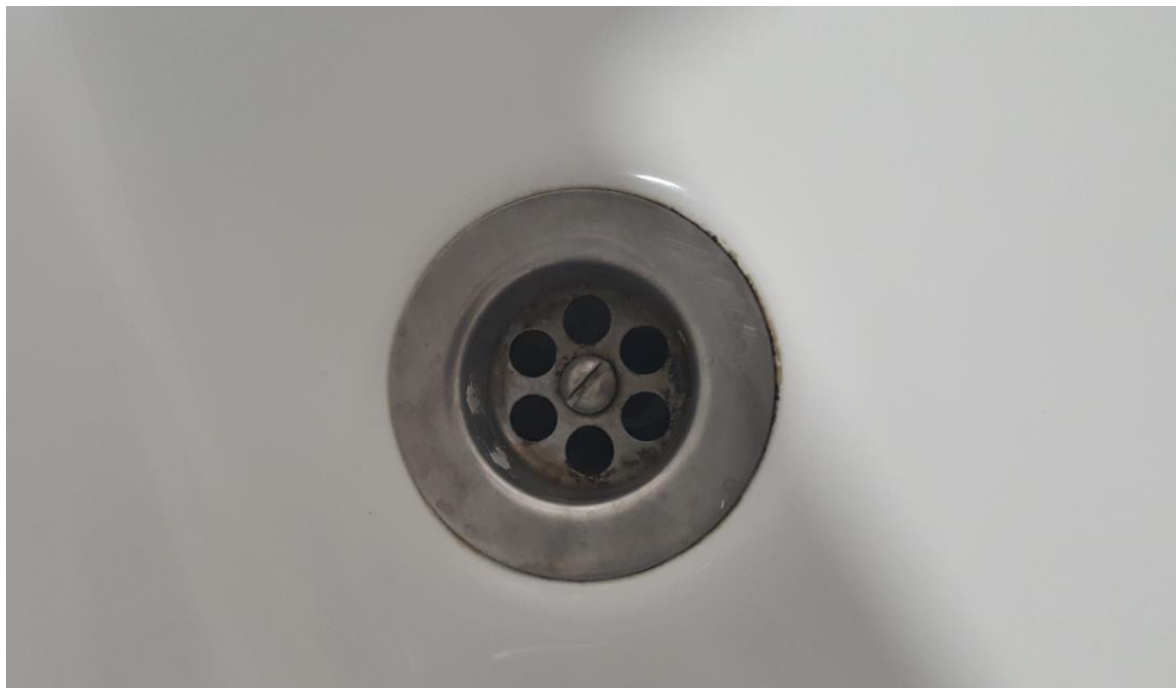
Fotografía 30. Baño Estación Marítima 2, Zona Planta baja – Recogida equipajes. Detalle de grifería oxidada.
