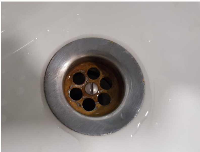
Fotografía 85. Baño Estación Marítima 3, Zona Planta baja – Embarque (Hombres). Detalles de desagües
