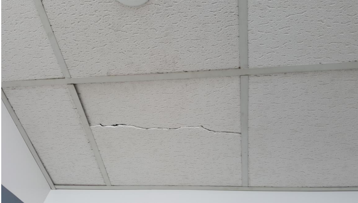
Fotografías 148. Baño Estación Marítima 5, Baños planta baja – Mujeres. Detalle de techos
