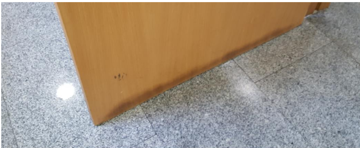
Fotografía 80. Baño Estación Marítima 3, Zona Planta baja – Hall (Hombres). Detalles de puerta principal
