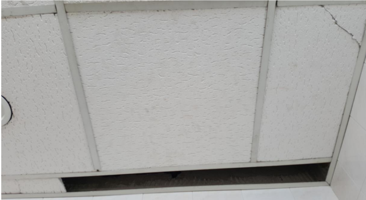
Fotografía 139. Baño Estación Marítima 5, Baños planta baja – Hombres. Detalle de techos
