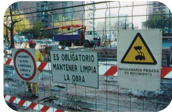
Ejemplo: señalización en zona de obras
