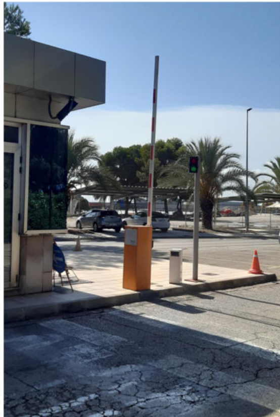
Ilustración 3. Báculo semáforo a sustituir
