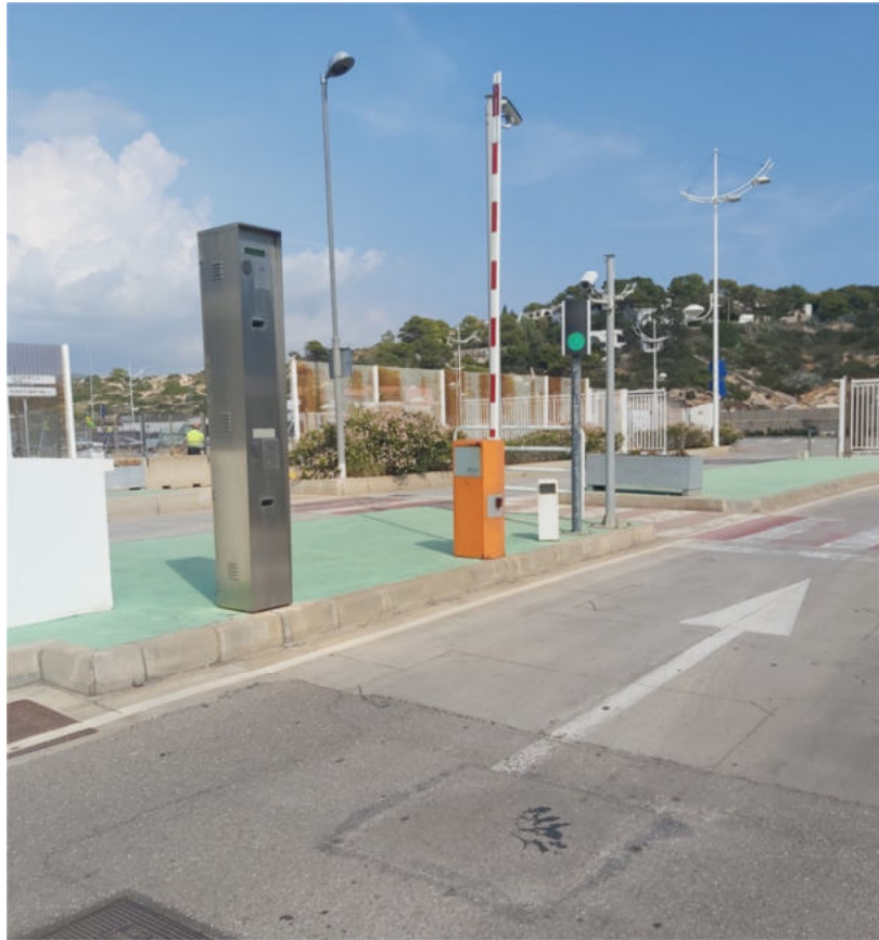
Il·lustració 5. Peana, barrera y cámara lectora de matrícules de vial de salida
