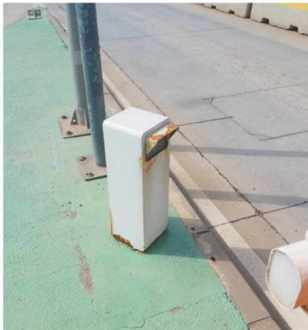
Il·lustració 4. Vista acceso desde parte interior (zona controlada)
