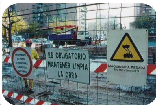
Ejemplo: señalización en zona de obras
