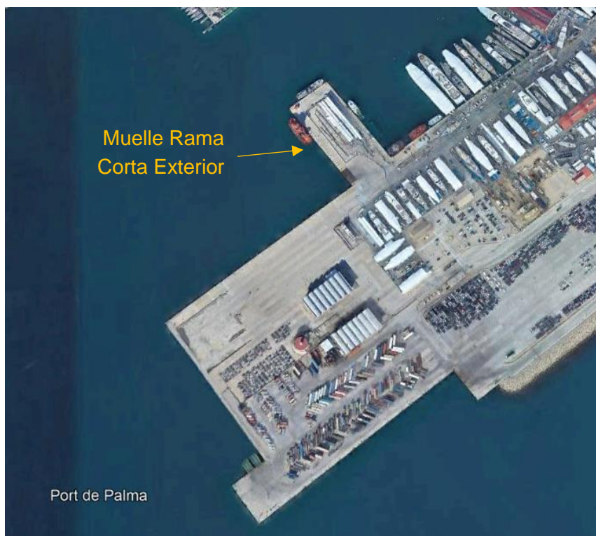
Figura 2. Localización del Muelle de la Rama Corta Exterior. Fuente: Google Earth
