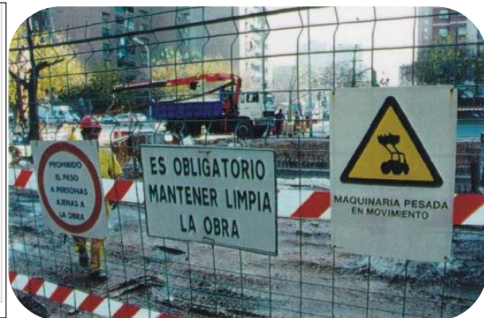
Ejemplo: señalización en zona de obras
